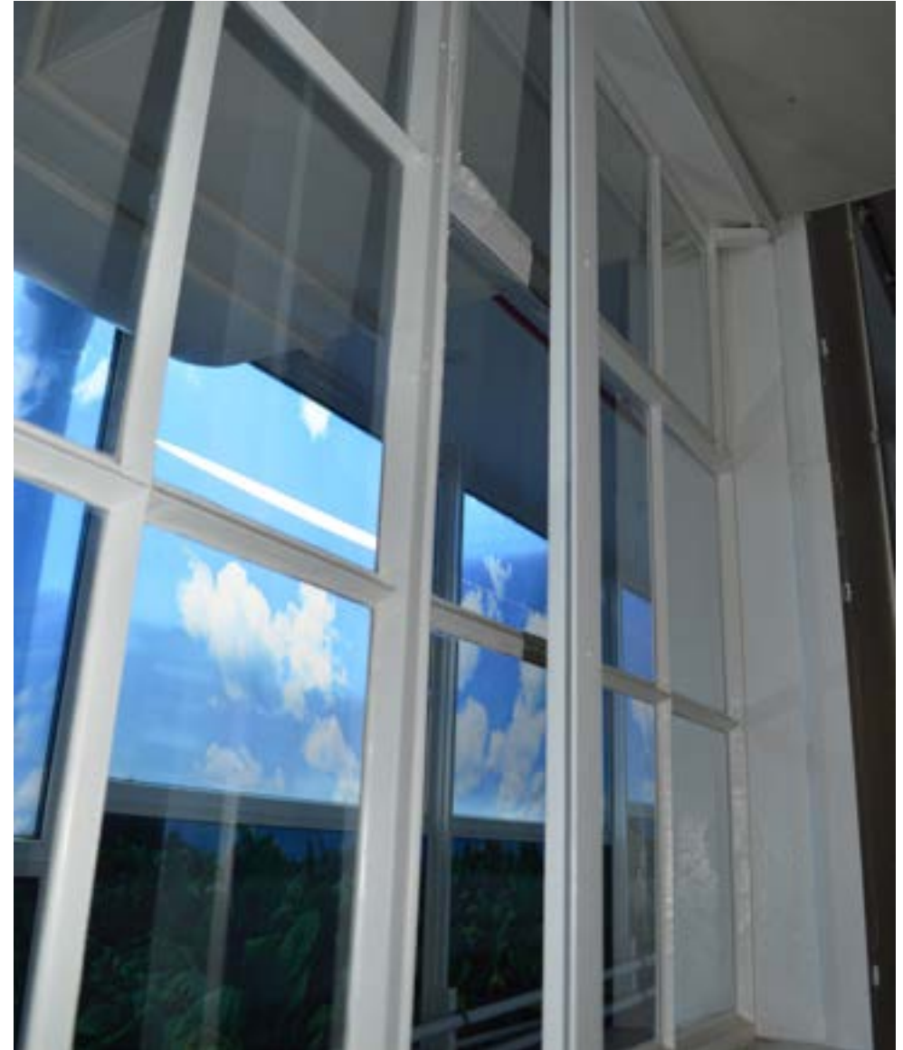
afbeelding 240. Detail uit voorgaande afbeelding van de ramen met ijzeren roedes en enkel glas (1925).
