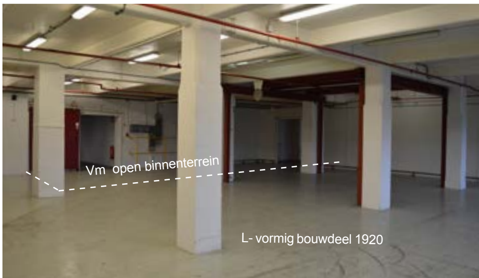
afbeelding 174. Ruimte 031A op de eerste verdieping van gebouw 2, gelegen in het in 1920 gerealiseerde bouwdeel, gezien richting de zuidgevel.
