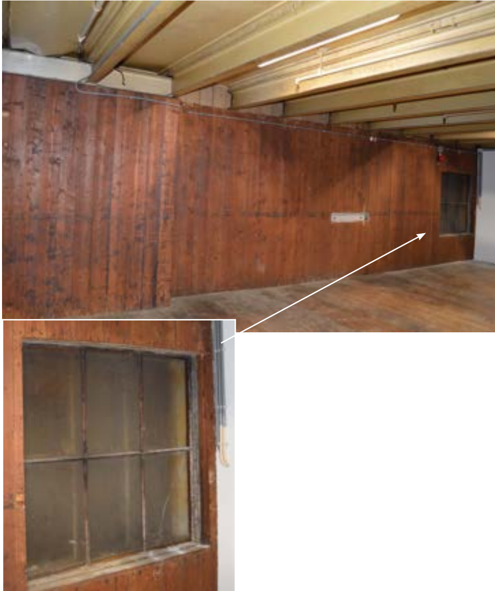
afbeelding 103. De werkplaats 033 gelegen langs de achtergevel van het pakhuis (gebouw 1). De ruimte wordt overspannen door stalen I-liggers. In de noordwesthoek van de ruimte bevindt zich een venster uit de bouwtijd met ijzeren roeden (1904).
