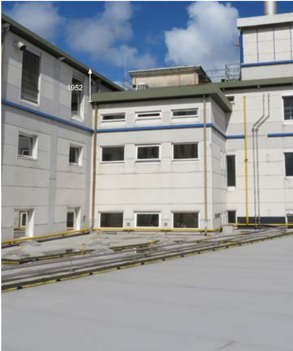
afbeelding 207. Detail uit voorgaande afbeelding van de aanbouw tussen gebouw 4 en 2 aan de zuidoostzijde. Toen gebouw 4 in 1952 werd opgehoogd, werd dit bouwdeel niet mee opgehoogd.
