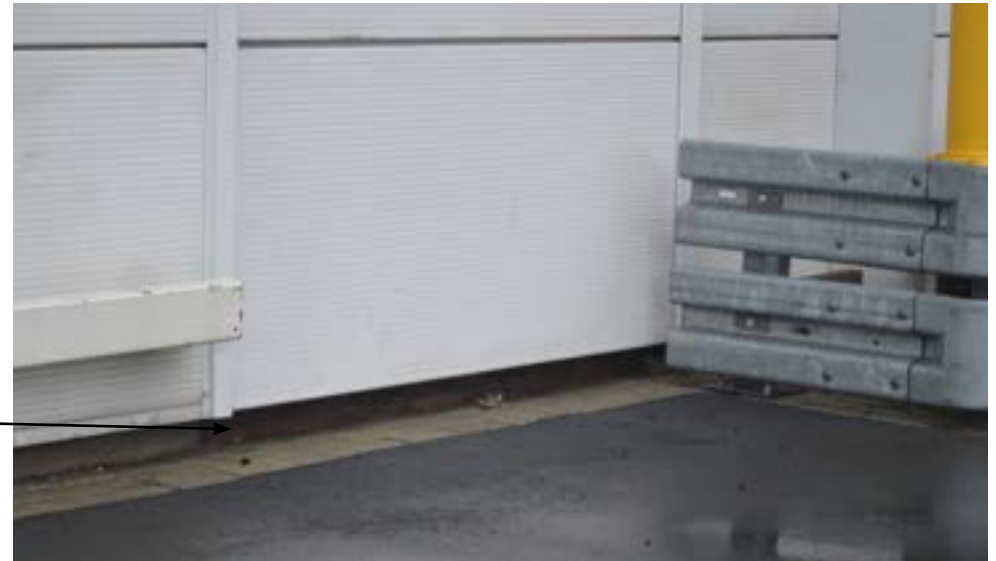
afbeelding 270. Plaatselijk is de gemetselde plint en de betonskeletconstructie onder de gevelbeplating (± 1992) zichtbaar.
