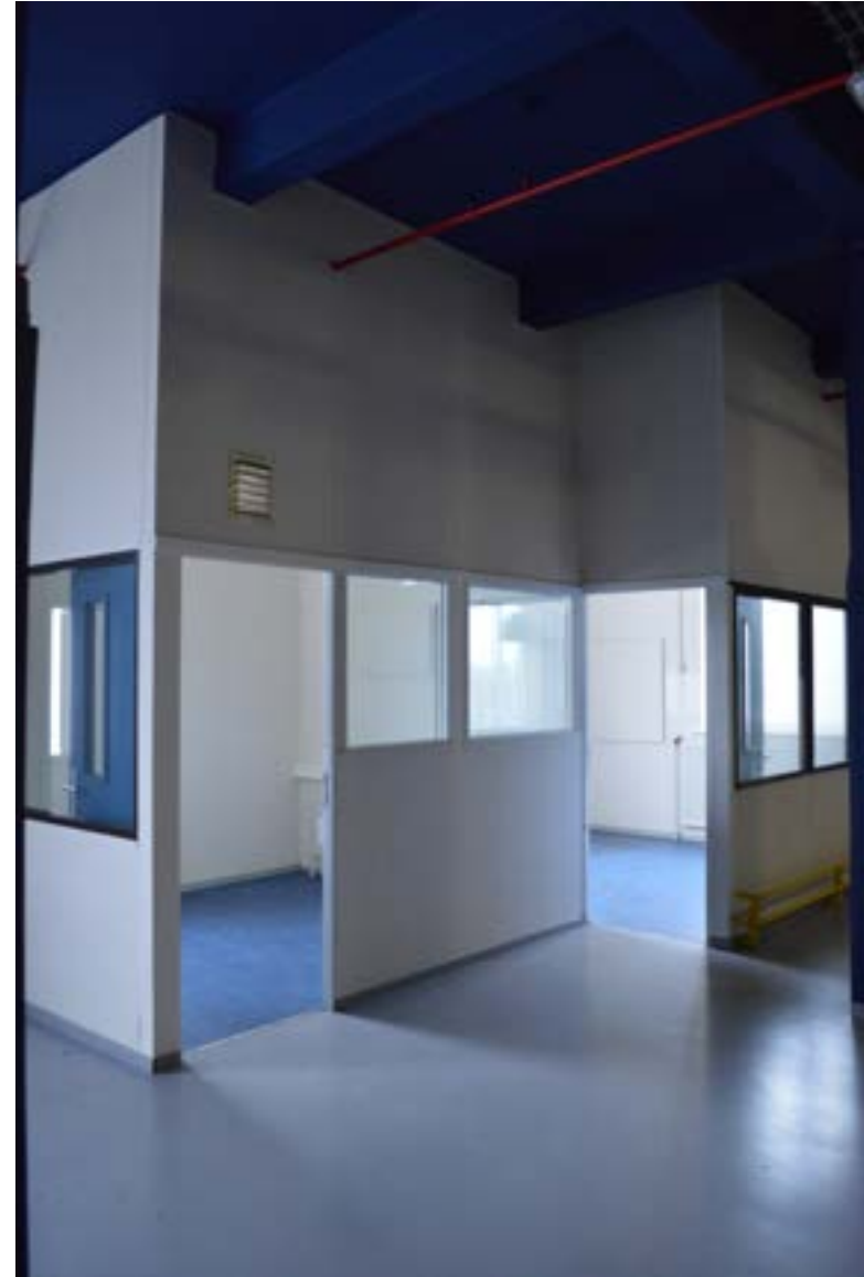
afbeelding 184. De het kantoor en rookruimte gerealiseerd in de zuidwesthoek van de fabriekshal (XXB).
