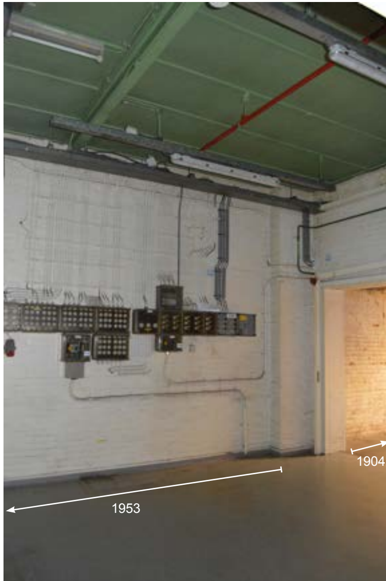
afbeelding 127. De zuidwesthoek van de werkplaats 026, met doorgang naar de pakhuistravee (west). De doorgang werd voorzien van stucwerk met velden (1953).
