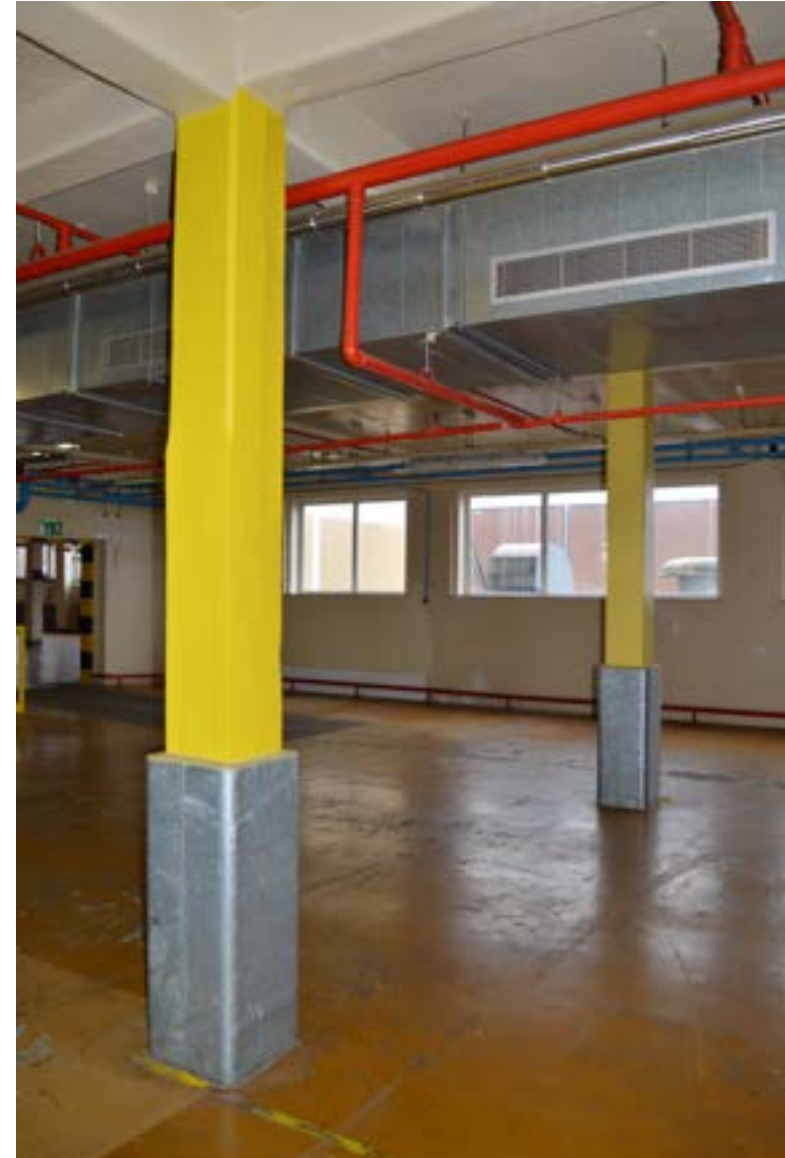
afbeelding 245. Detail van de gewapende betonnen kolommen - voorzien van een vellingkant - en balken - voorzien van afgeronde hoeken (1925).
