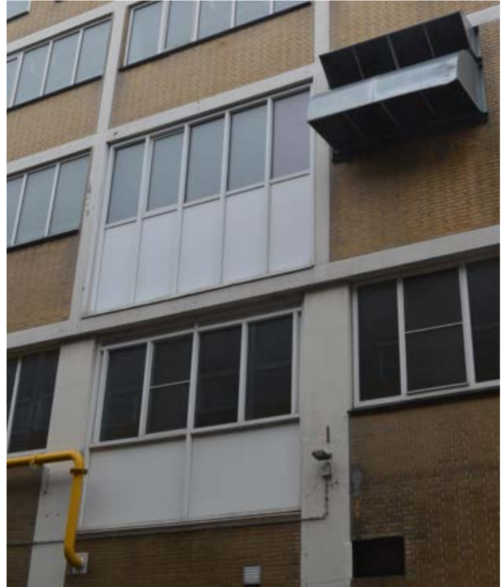
afbeelding 262. Detail van de vergrote gevelopeningen in de tweede travee vanaf het westen; deze werden vermoedelijk omstreeks 1975 gerealiseerd en in de jaren 1990 weer dichtgemaakt met behulp van de huidige kozijnen met kunststof panelen.
