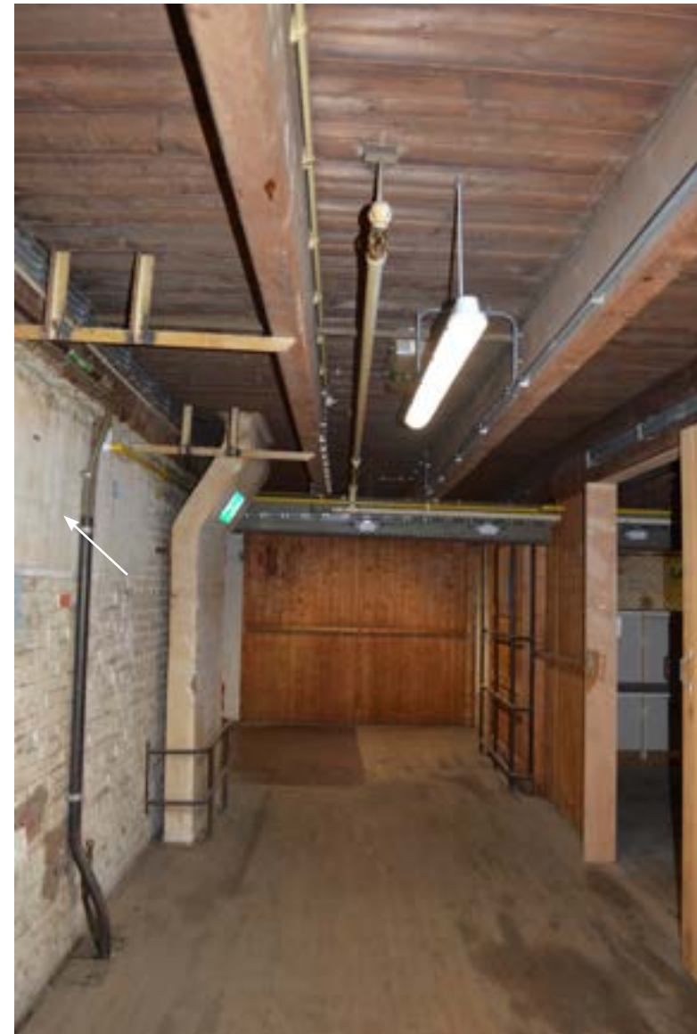
afbeelding 128. Gang 031A, in de pakhuistravee, gezien richting de westgevel. Aan de linkerzijde bevindt zich de voormalige buitengevel (zuid, 1904) van de pakhuistravee; in de muur tekenen zich de oude vensteropeningen af (zie pijl).
