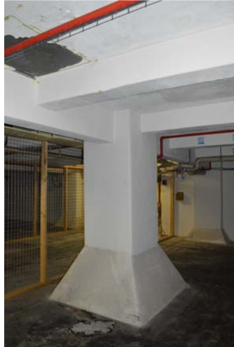
afbeelding 159. Detail van een gewapende betonkolom (1913), voorzien van een tapstoelopende kolomvoet. De betonnen kolommen en balklagen bevatten geen vellingkanten.
