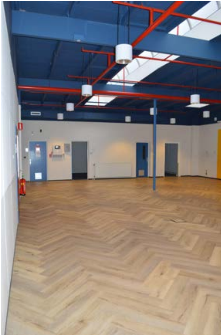
afbeelding 96. Gang 018, gezien richting het zuiden (interieur XXd). Deze ruimte betreft het in 1940 overkapte binnenterrein. Eind 20ste eeuw werden de glaskap en de ijzeren spantconstructie uit 1940 verwijderd en werd de huidige dakconstructie met kunststof lichtkoepel voorzien (XXd).
