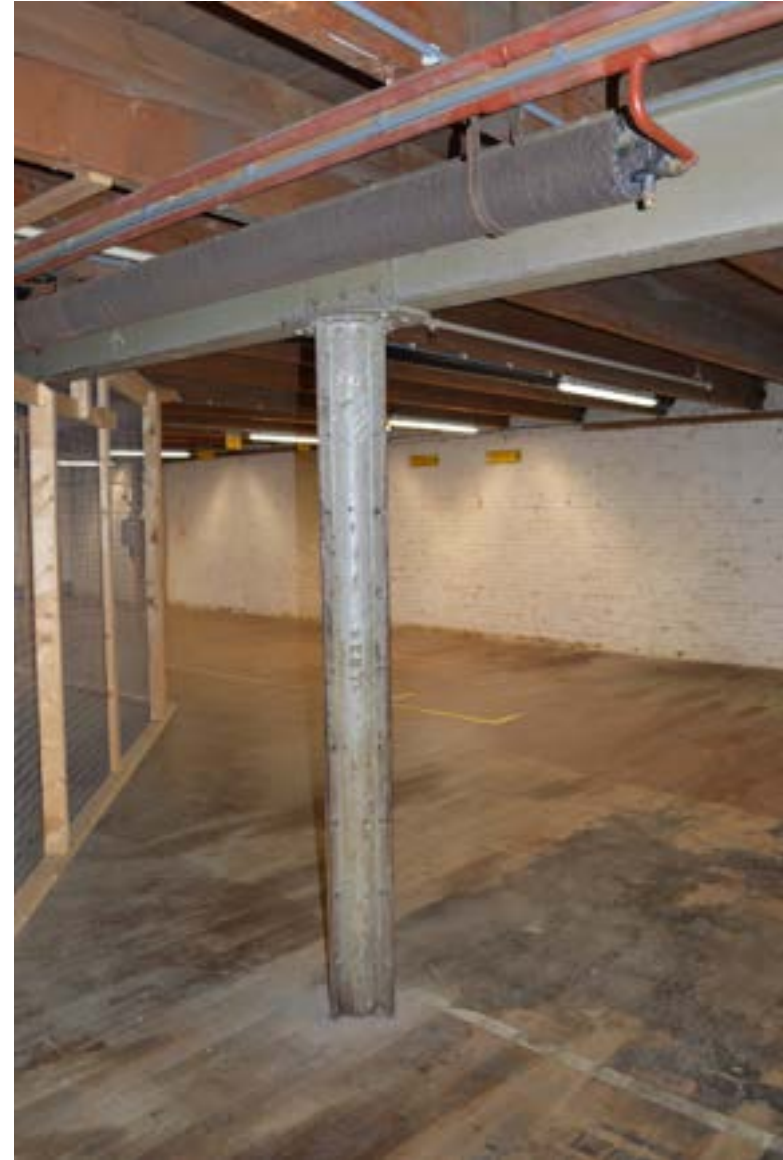
afbeelding 135. Detail van stalen buiskolom en onderslagbalk voor de houten balklaag die het dak draagt (1904).
