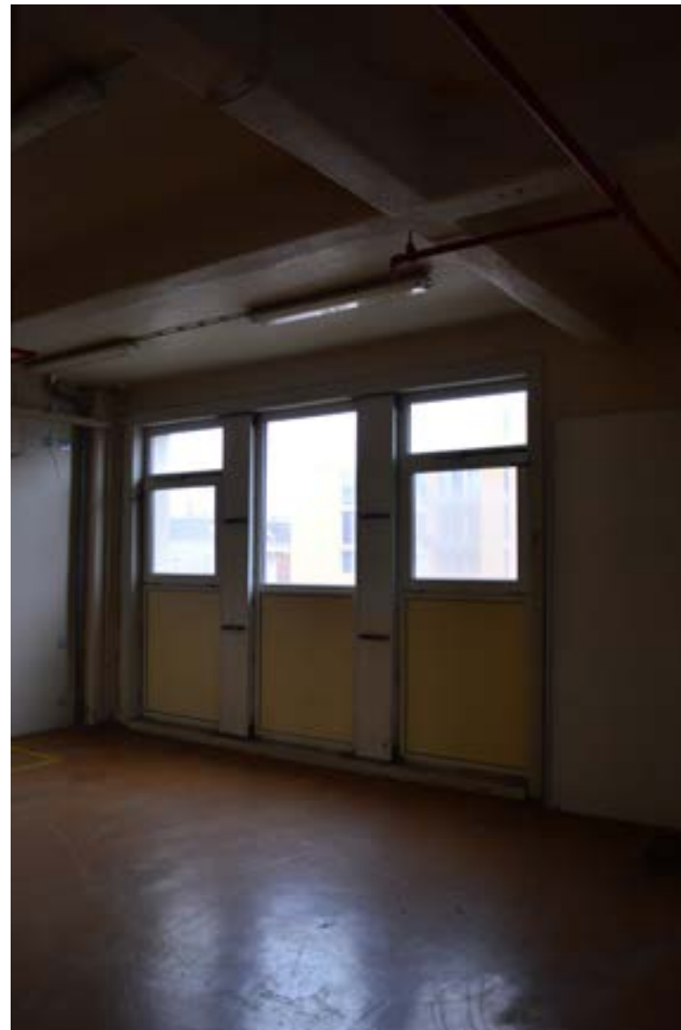
afbeelding 170. Detail uit voorgaande afbeelding van de vensters in de oostgevel (XXd).
