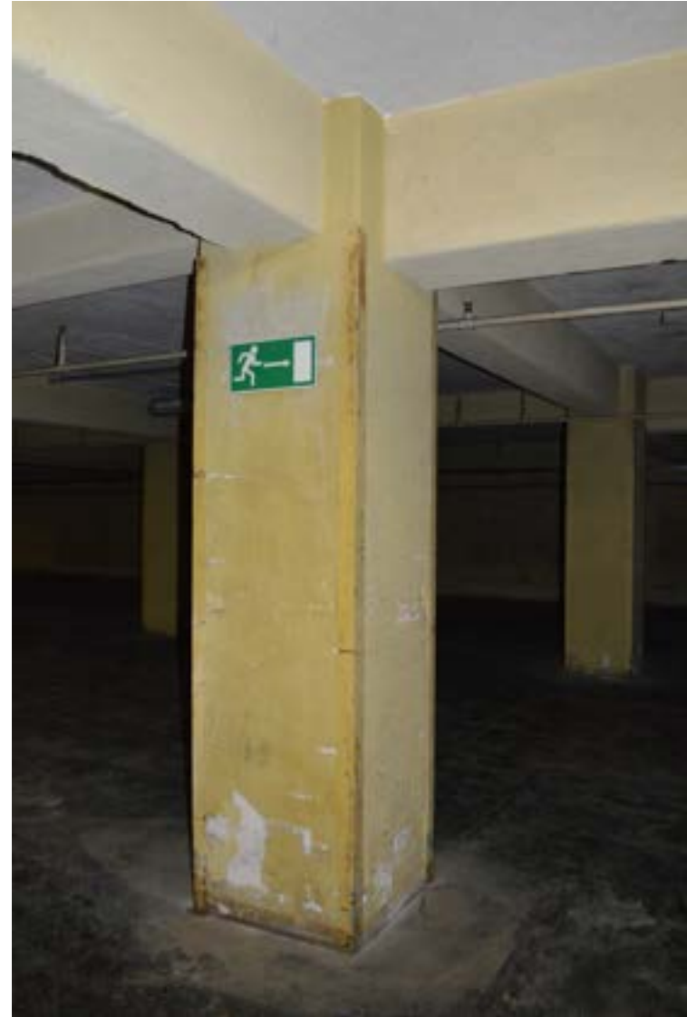
afbeelding 216. Detail van de kolom uit voorgaande afbeelding (1925); deze bevat geen kolomvoet, werd voorzien van stalen hoekprofielen en een vellingkant.
