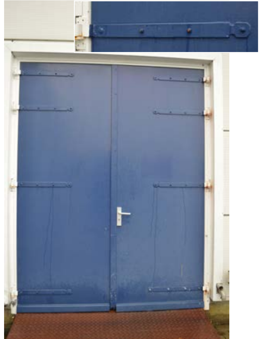
afbeelding 268. Dubbele buitendeur in de westgevel, voorzien van acht forse deurgehengen (XXd).
