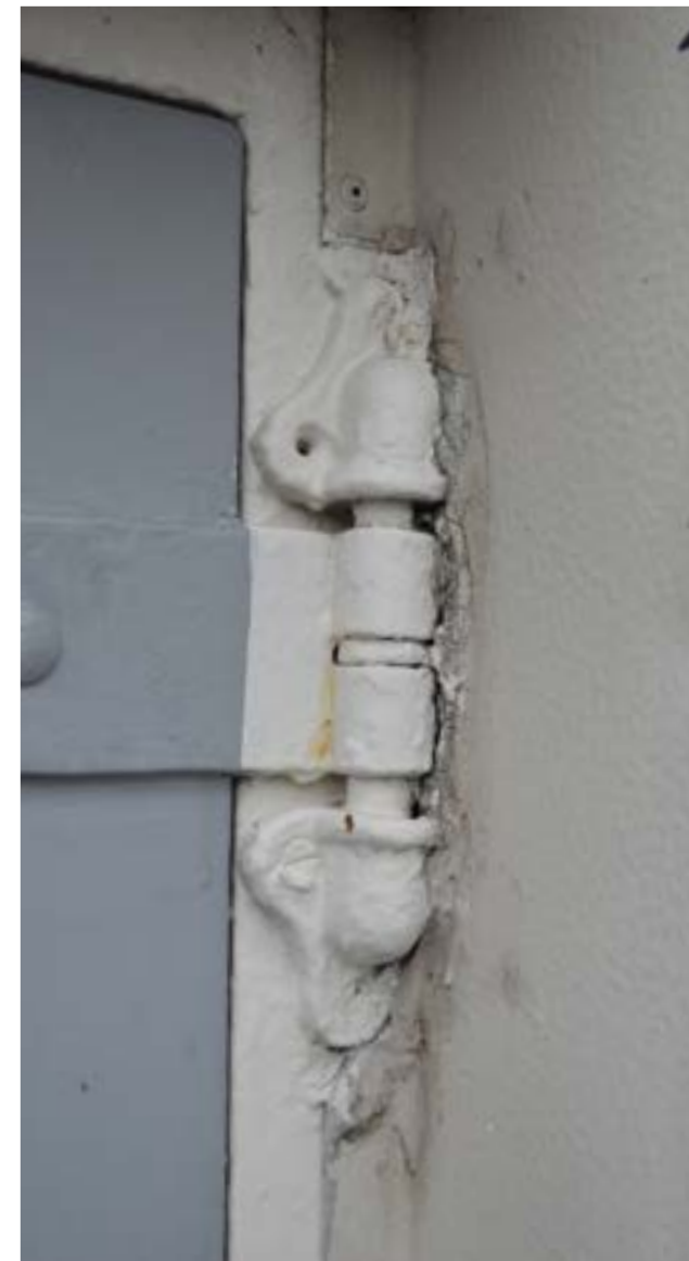
afbeelding 274. Detail van scharnieren en gehengen van de deuren uit voorgaande afbeeldingen (1950).
