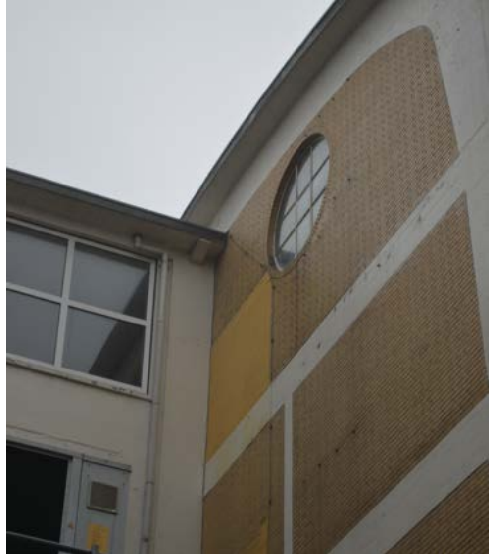
afbeelding 260. Voor het zichtwerk van het betonskelet werden in de bekisting ter afwerking geschaafde houten delen aangebracht (1950). De oostgevel bevat ter hoogte van de derde en vierde verdieping twee gecementeerde, in geel afgewerkte vlakken.
