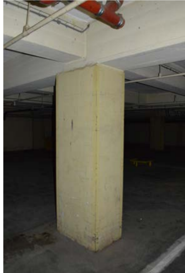
afbeelding 286. Detail van een betonnen kolom, rechthoekig en ter bescherming afgewerkt met stalen hoekijzers. Op de gestorte betonnen balken zijn de afdrucken van de planken van de houten bekisting zichtbaar (1950).
