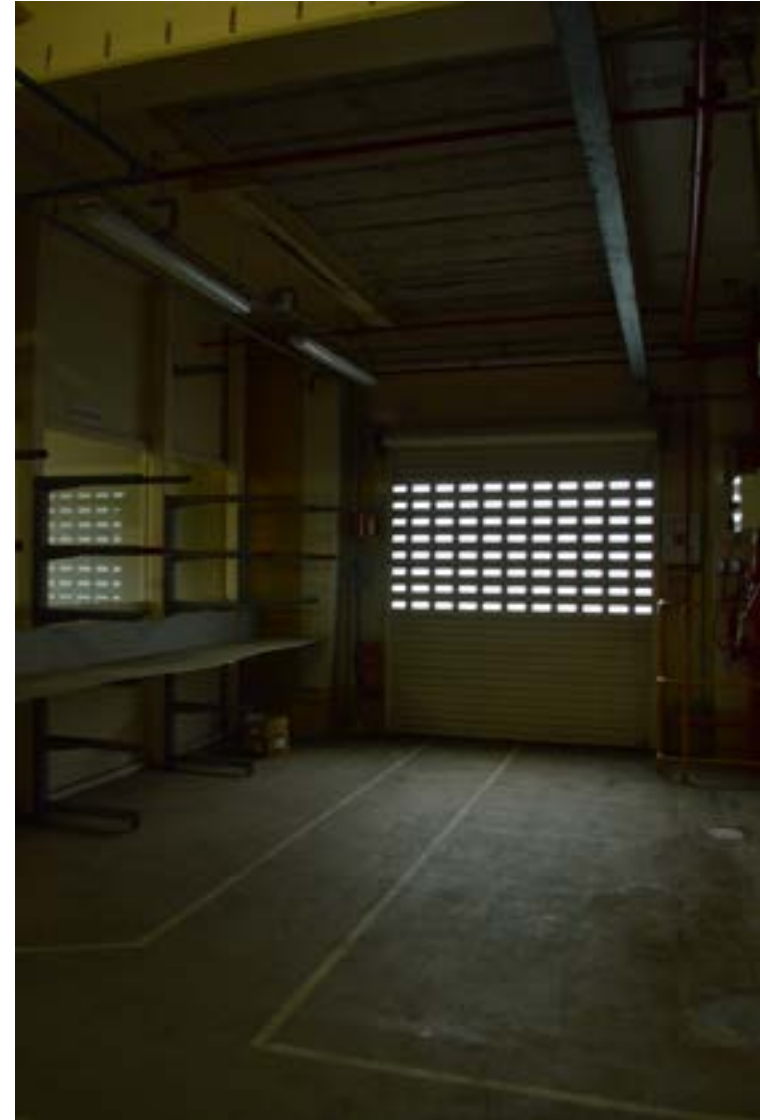
afbeelding 297. De gevelopening voorzien van een garagedeur, centraal gelegen in de westgevel (1950). De huidige garagedeur werd recent ingebracht (1990 >).
