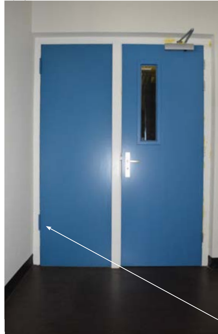
afbeelding 235. Deur naar de fabriekshal, vanuit de traphal 041. De deur is voorzien van gelagerde scharnieren met bolkoppen (1925).
