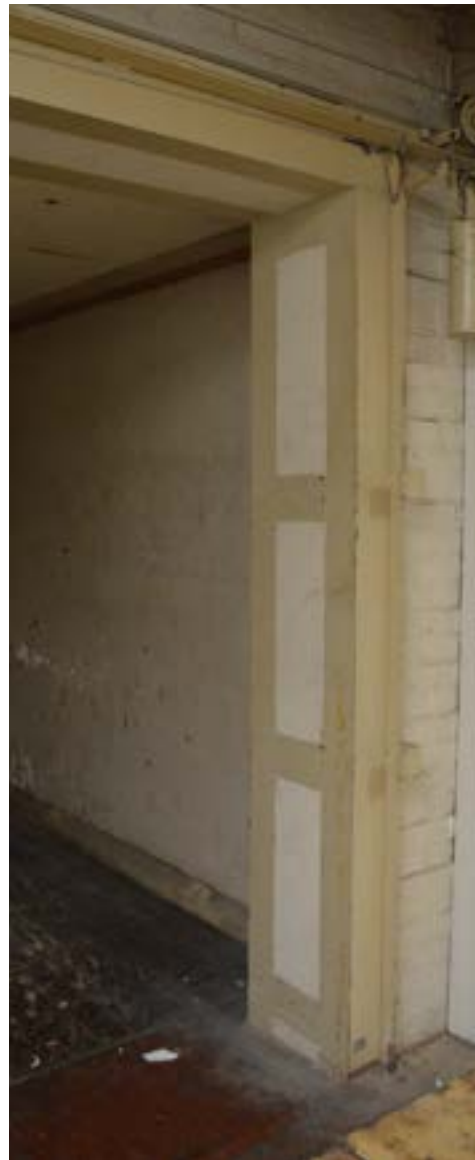
afbeelding 110. Detail uit ruimte 026; lambrisering uit houten delen met v-groef.
