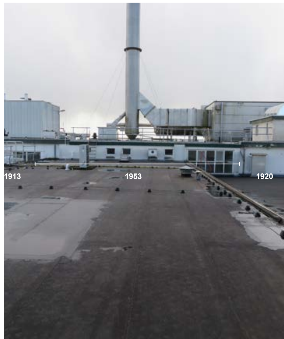
afbeelding 147. De noordgevel van gebouw 2, gezien vanaf het platte dak van gebouw 1. Gedurende de bouw van het westelijk deel van gebouw 2 (1920) werd een open binnenplaats voorzien. Deze werd in 2 fasen (XXb en 1953) volledig bebouwd, waarvan hier (gemarkeerd) het in 1953 opgebouwde deel zichtbaar is.
