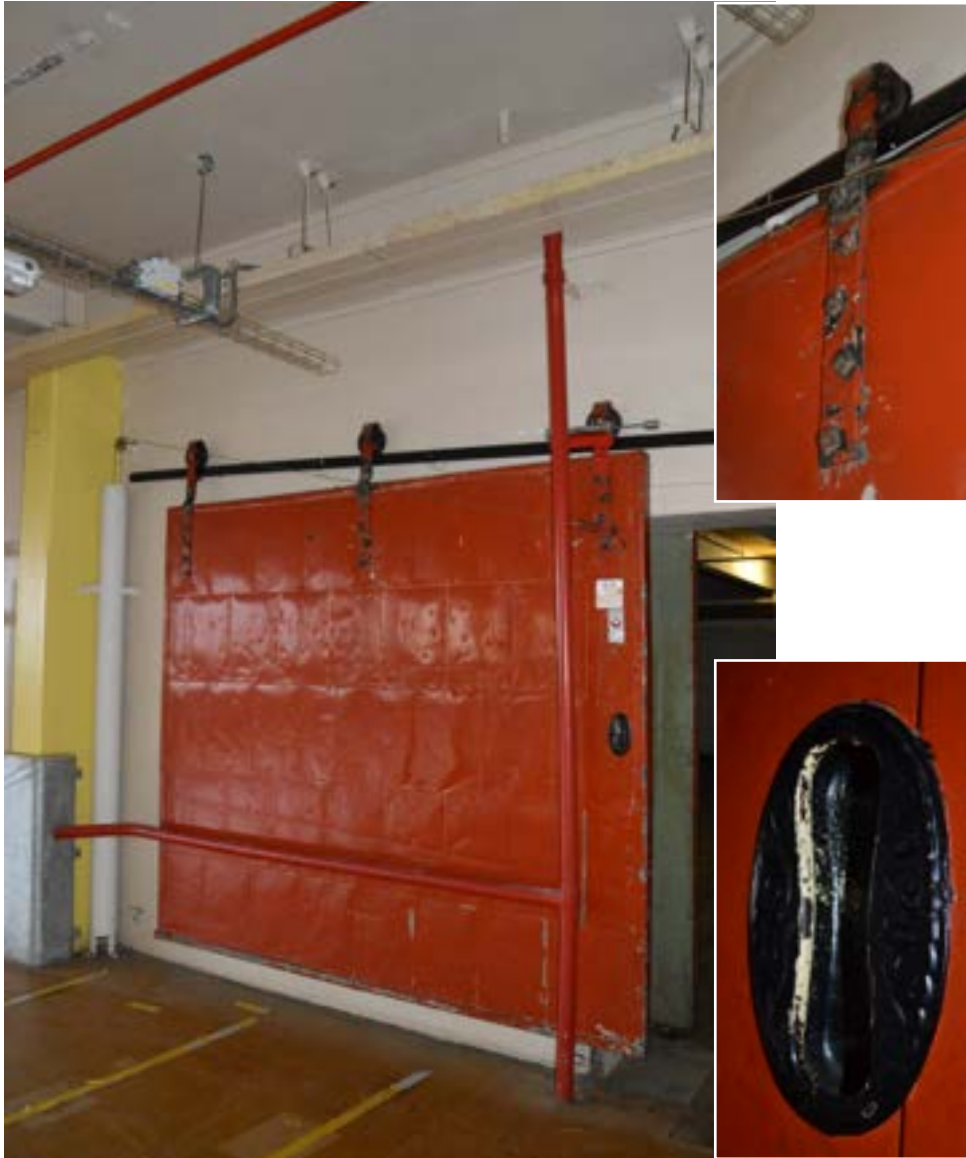
afbeelding 246. De tweede branddeur richting het voormalige pakhuis in gebouw 1, in de oostmuur; als hangdeur op een rails gemonteerd en voorzien van een ovale greep (1925).
