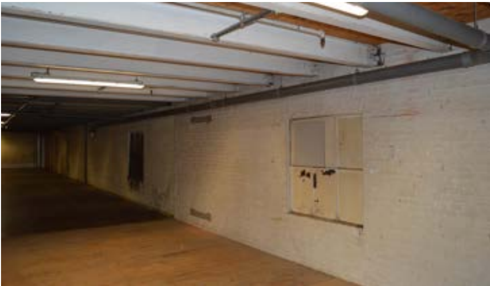
afbeelding 113. De derde - tussen - verdieping van het pakhuis, 037 gelegen in de meest westelijke travée van gebouw 1, gezien richting het zuidwesten.
