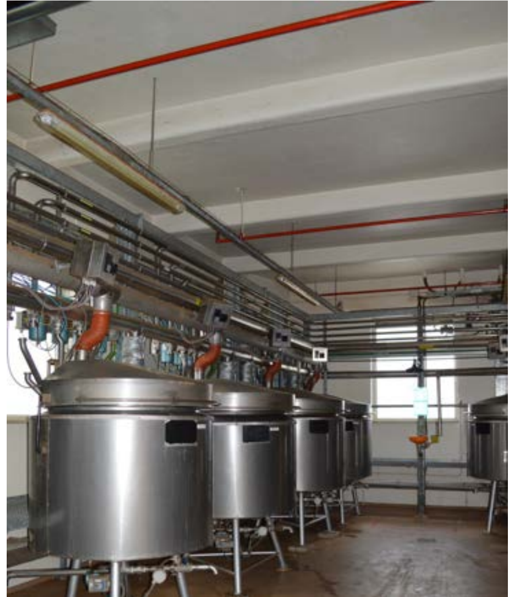
afbeelding 192. Een van de weinige overgebleven installaties in het fabriekscomplex (mogelijk de ketels waar de tabakssaus in werd geproduceerd); gelegen in de zuidwesthoek van het in 1920-21 gerealiseerde bouwdeel.
