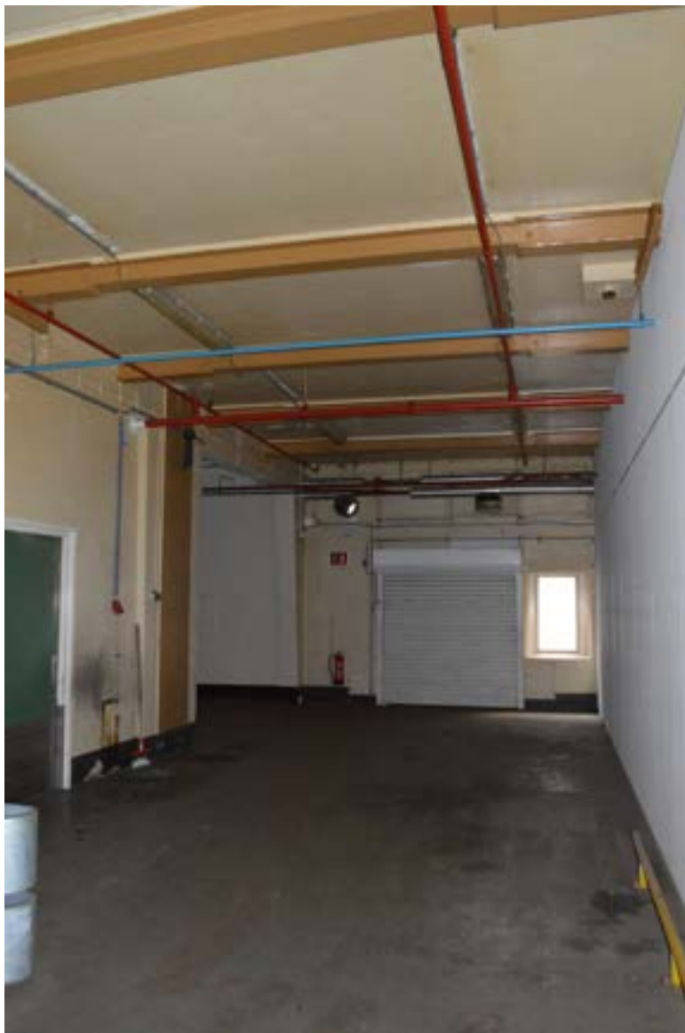
afbeelding 291. Zicht vanuit de brede tussengang (083), richting de noordgevel. In de noordgevel werd hier een garagedeur met venster ingebracht (1990 >). Ook hier zijn de stalen liggers (DIN 18), opgelegd op de in 1953 gestorte betonnen portalen in het zicht.
