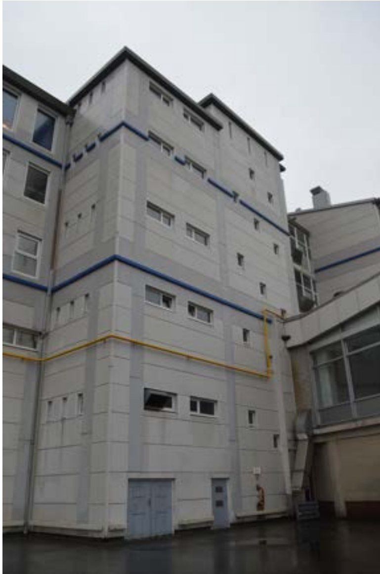
afbeelding 271. De aanbouw aan de zuidoostzijde van gebouw 6 uit de bouwtijd (1950), waarin het sanitair, het trappenhuis en de goederenlift werden ondergebracht.
