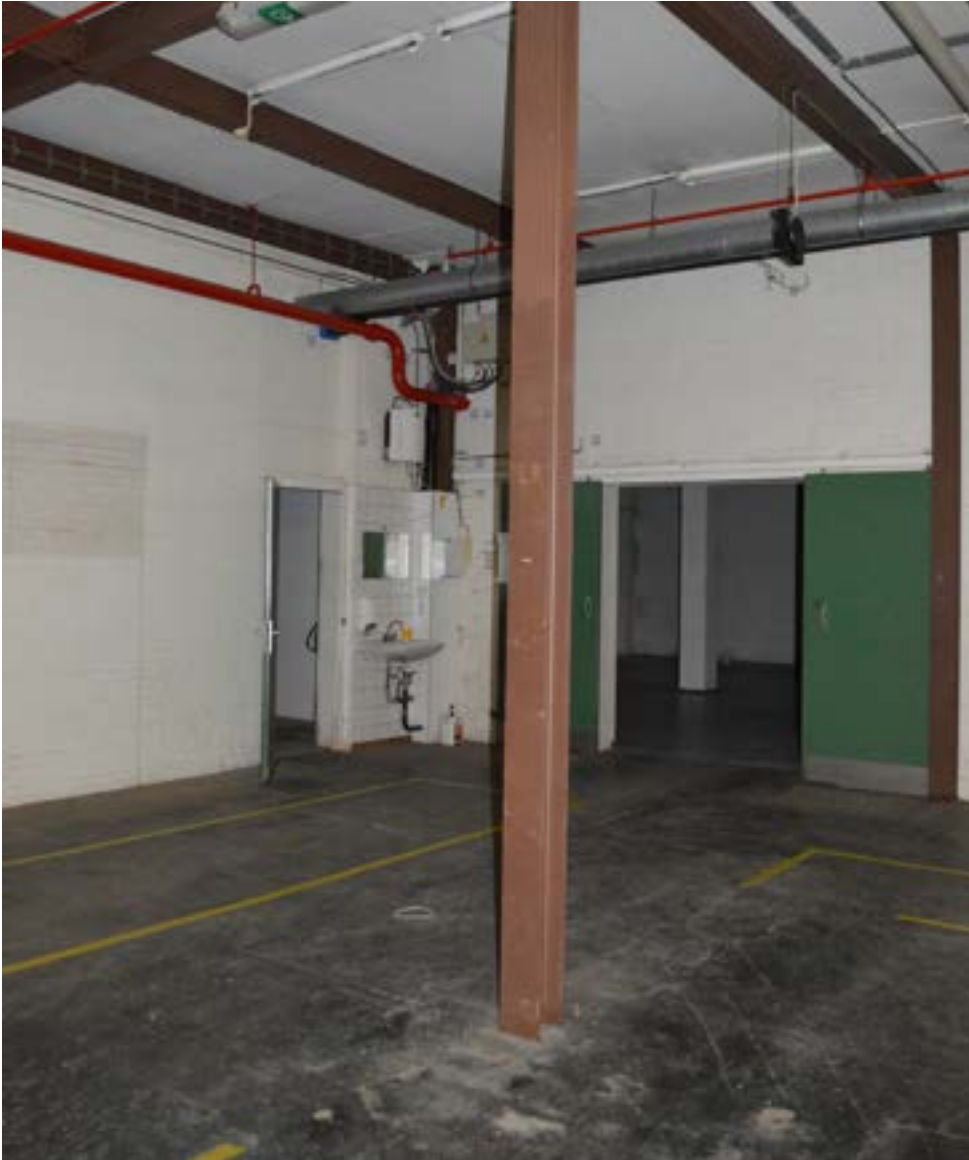
afbeelding 52. Technisch magazijn 030 gezien richting het zuidwesten, met de voormalige zuid- en westgevel van de binnenplaats. Diverse bouwsporen van voormalige gevelopeningen tekenen zich af.
