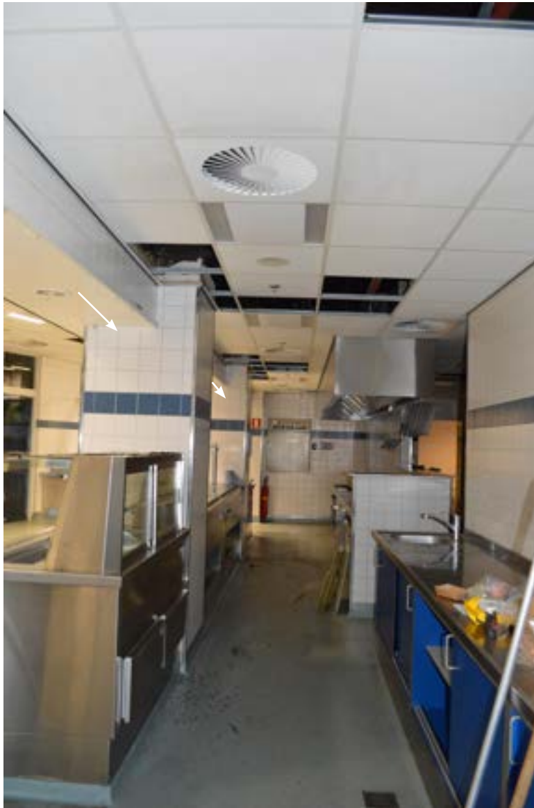
afbeelding 228. De keukenuitgifte 057, gezien richting het westen; in lijn van de kolommen lag de in 1961 grotendeels weggebroken zuidgevel van gebouw 4 (1925) (interieurafwerking XXd).
