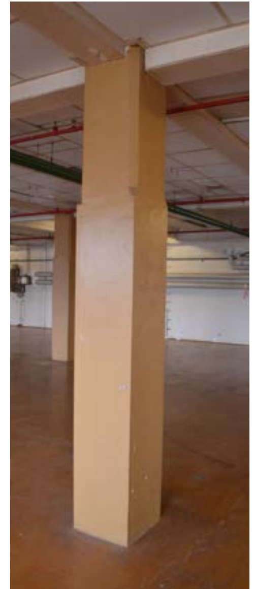
afbeelding 172. Kolom uit het in 1913 gerealiseerde bouwdeel.
