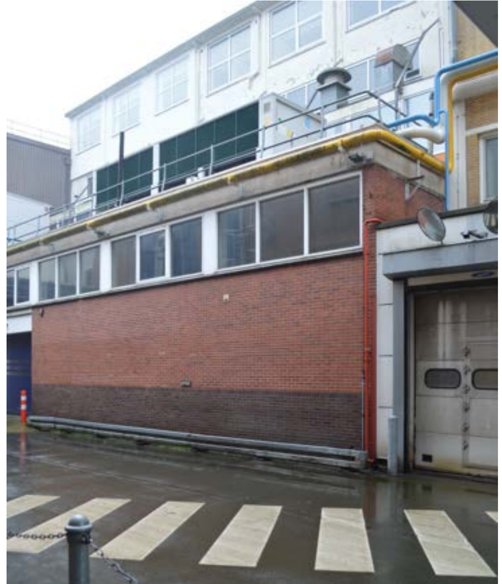
afbeelding 210. De noordgevel van gebouw 4 gezien vanaf het maaiveld. De de hoge eenlaagse aanbouw tegen gebouw 4 werd in ± 1940 gerealiseerd. De huidige garagedeuren, vensters en dakvorm van dit bouwdeel werden tussentijds gewijzigd (XXB).
