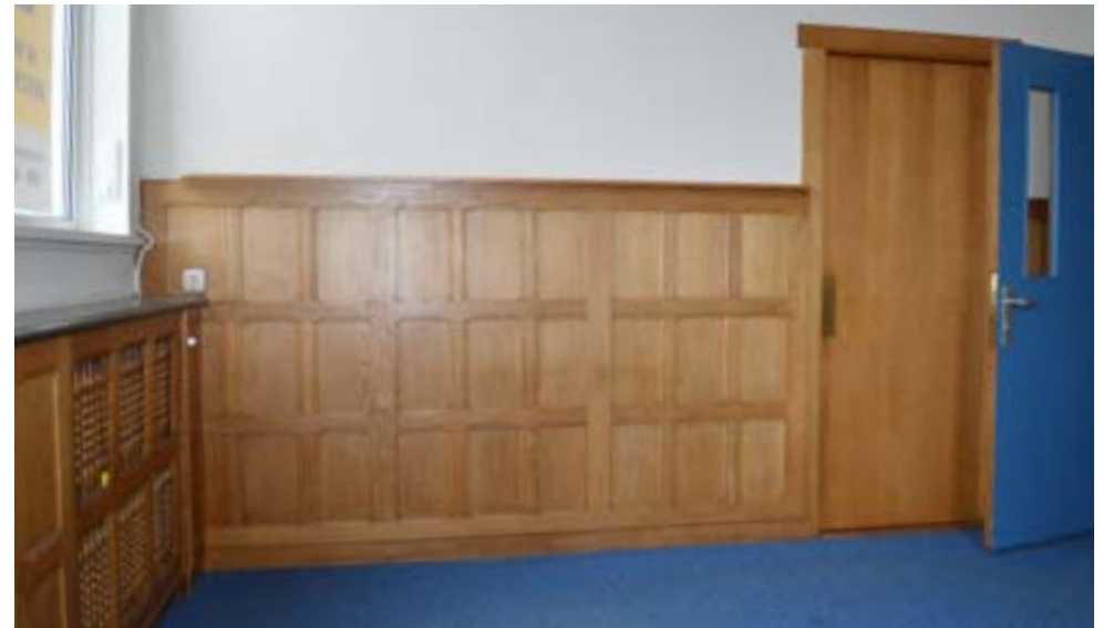
afbeelding 77. Kantoor 005, gelegen in de noordoosthoek van de in 1910 gerealiseerde eerste verdieping van de travee aan de voorzijde (oost).
