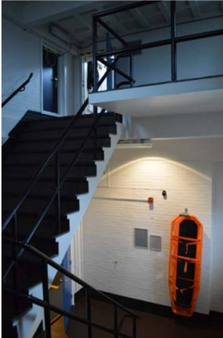
afbeelding 342. Het trappenhuis richting de dakopbouw 045 van gebouw 6 (1950).
