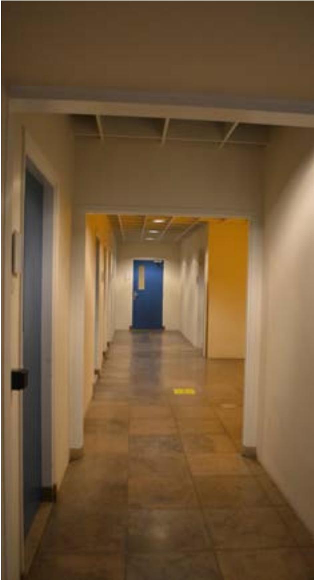
afbeelding 42. Gang 008 gezien richting het zuiden, met aan de rechterzijde de huidige inrichting met toiletgroepen (gedeeltelijk t.p.v. de voormalige binnenplaats), deze inrichting kwam in 1969 tot stand.
