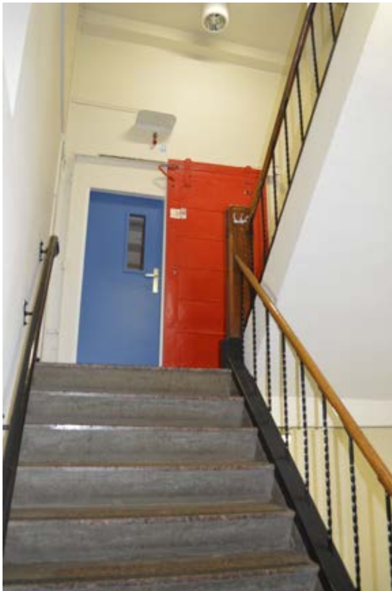
afbeelding 185. Het trappenhuis 041/007, gelegen aan de noordwestzijde van gebouw 2 (1920).
