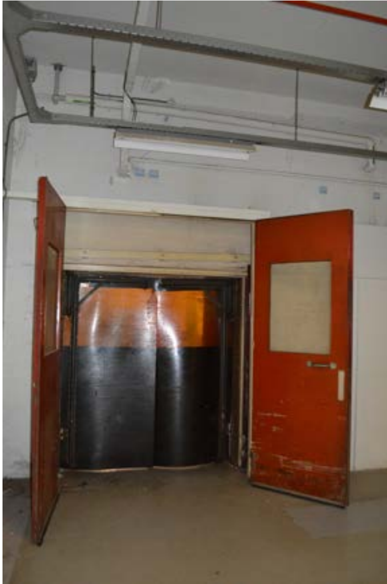
afbeelding 59. Deur naar achterste travee (west) van gebouw 1, waarachter het voormalige pakhuis (1904) gelegen was.
