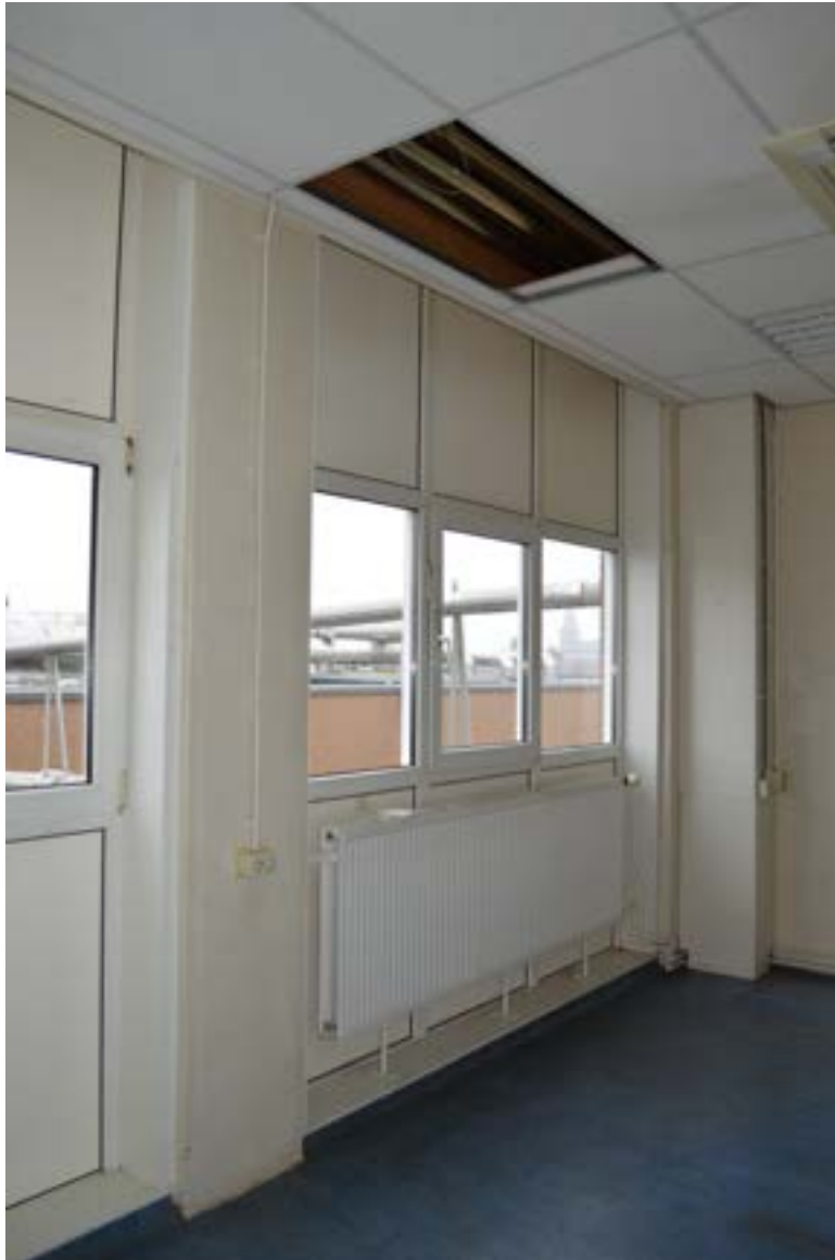
afbeelding 126. Het kantoor in de noordoosthoek 027 van de werkplaats, gezien richting het noordoosten (interieur en schrijnwerk XXd).
