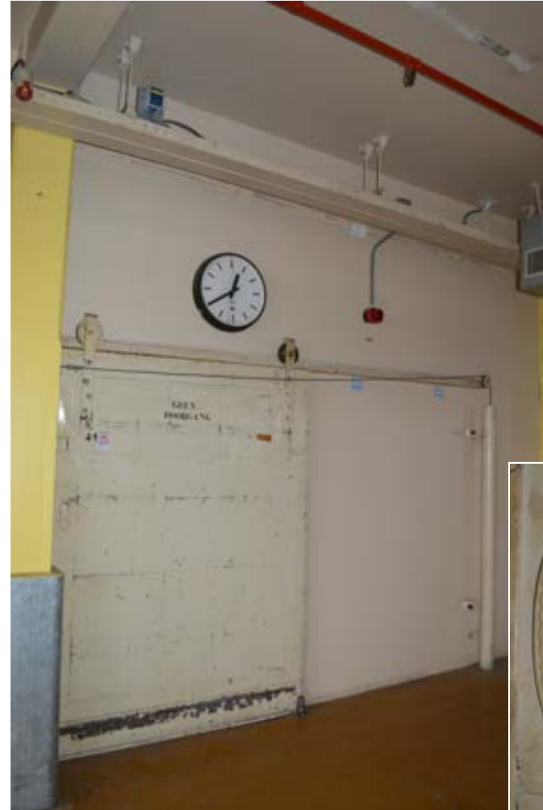
afbeelding 244. De branddeur richting het voormalige pakhuis in gebouw 1, in de oostmuur, voorzien van een ovale handgreep (1925).
