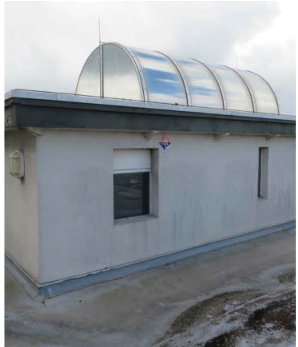
afbeelding 151. Detail van de dakopbouw van het trappenhuis met lift aan de noordwestzijde van gebouw 2 (1920). De lichtkoepel en het venster links werden secundair ingebracht (XXd).
