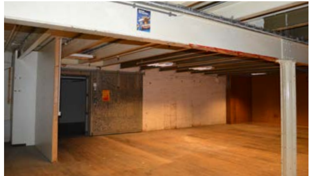
afbeelding 104. Magazijn 029 (XXc), gezien richting het westen.
