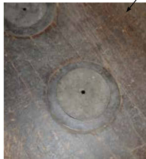
afbeelding 112. Details uit ruimte 026: In de vloer bevinden zich in deze huidige gang ijzeren ringen met ronde afdekkappen. De voormalige zuidgevel bevat sporen van diverse oudere afwerkingen.
