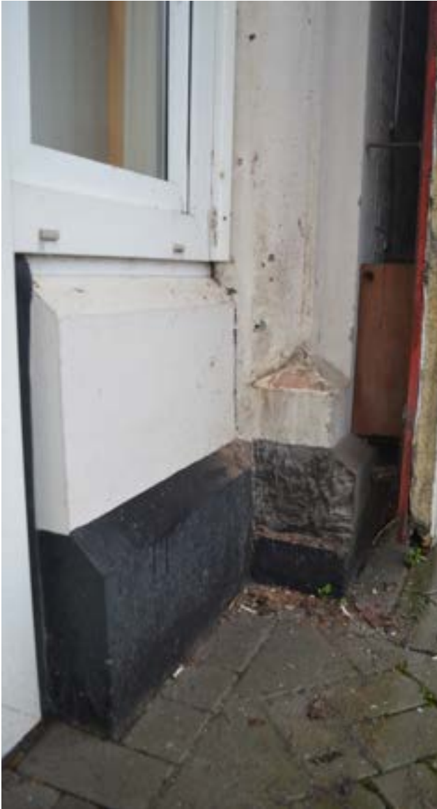
afbeelding 19. Twee details uit voorgaande afbeelding van de dagkant van de poortdoorgang waar de gevelpanelen (XXd) gedeeltelijk werden weggenomen. Het basement, aanzetstenen en sluitsteen van de rondboog werden vervaardigd uit gefijnde geprofileerde zandsteenblokken (1904), de overige onderdelen van de dagkant werden vervaardigd uit geprofileerde bakstenen, die later werden voorzien van pleisterwerk.
