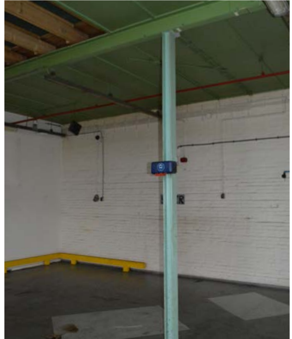
afbeelding 123. De constructie van de opgebouwde verdieping uit 1953 werd gerealiseerd uit ranke kolommen (DIN 10), waarop een I-profiel met houten balklaag ter ondersteuning van het dak rust. De vloer werd uitgevoerd als gewapende betonvloer (1953).
