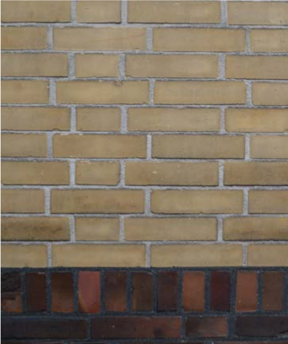
afbeelding 263. Het metselwerk van gebouw 6 is opgetrokken met een plint uit paarbruinde baksteen met hierop een gele Groninger genuanceerde baksteen, gemetseld in een variant op noors- of kettingverband met telkens 3 strekken gevolgd door 1 kop (1950).
