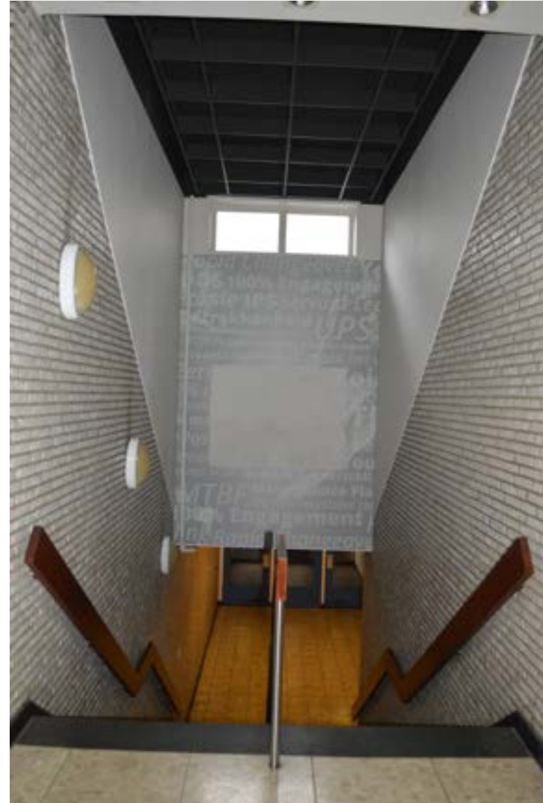
afbeelding 224. De trap (in gang 042) en gang richting de aanbouw aan de noordzijde van gebouw 4, werden in 1961 gerealiseerd.
