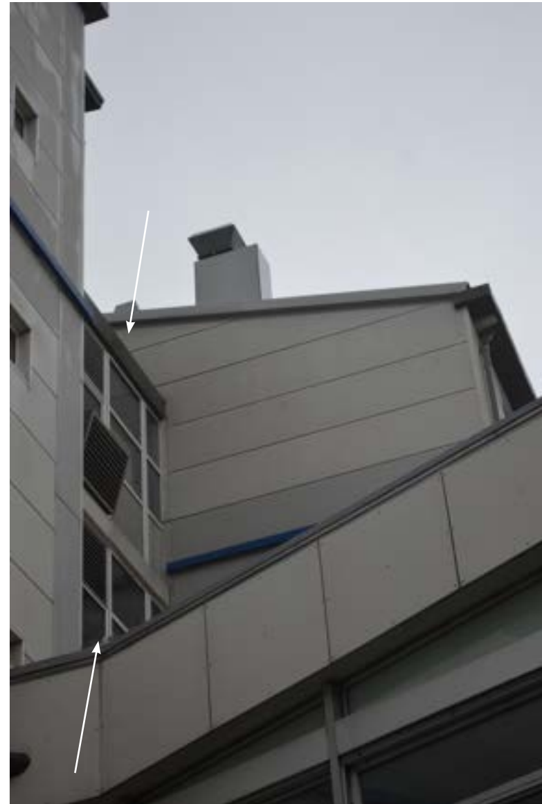
afbeelding 208. Zuidelijk deel van de westgevel van gebouw 4. Tussen gebouw 4 en 6 werd in 1960 een tussenliggende aanbouw met vliesgevel gerealiseerd (zie pijl).
