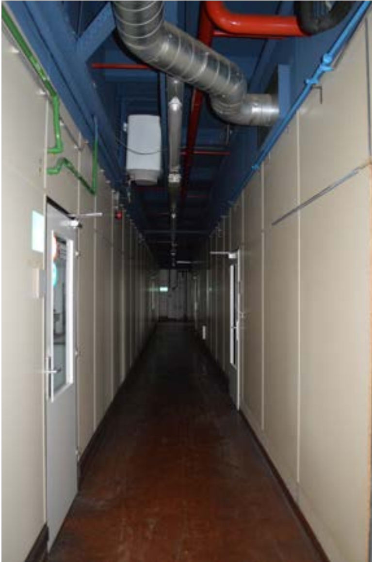
afbeelding 198. Gang 005, gezien richting het oosten, met aan de linker- en rechtzijde de laboratoria.
