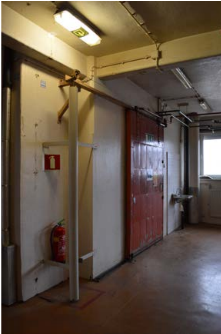
afbeelding 171. De branddeur richting het trappenhuis aan de zuidoostzijde (033), bevestigd op een schuifrails (werkzaam d.m.v. smeltlood).
