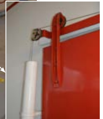
afbeelding 319. De branddeur tussen gebouw 4 en 6, voorzien van een hang-schuifrails met contragewicht (1950).
