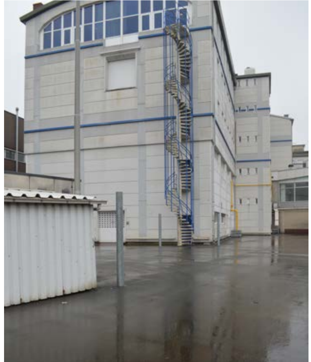
afbeelding 264. De westgevel, gezien vanuit het zuidwesten. De zuid- en westgevel werden in ± 1992 voorzien van de huidige gevelbekleding uit platen.
