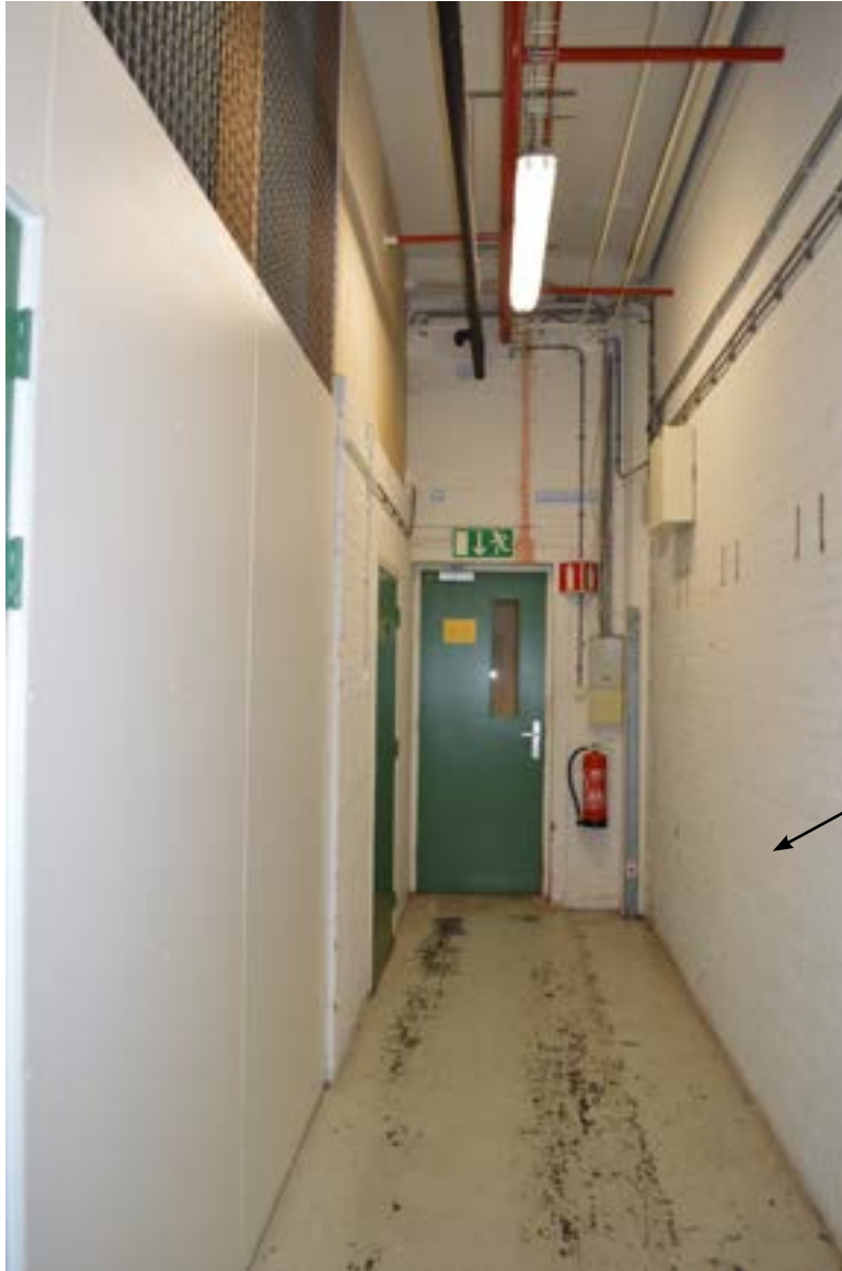
afbeelding 50. Gang 004A gezien richting het noorden, gelegen op het voormalige open binnenterrein.
