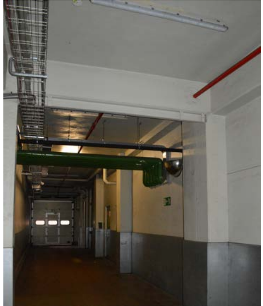
afbeelding 222. De overdekte doorrit (075) aan de westzijde van gebouw 4
