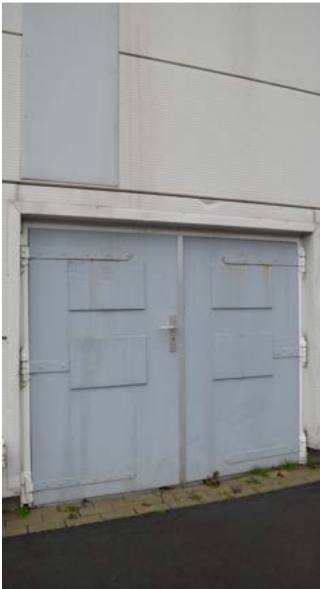
afbeelding 273. Detail van de buitendeuren uit de bouwtijd (1950). De roosters en het deurbeslag werden later voorzien.
