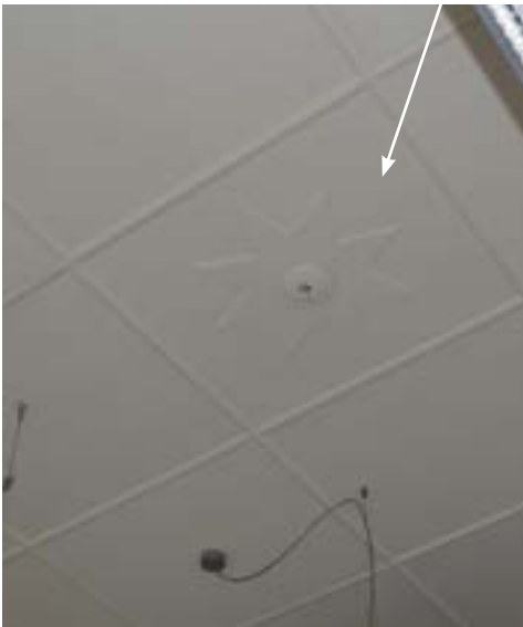
afbeelding 79. Het plafond werd gestuct en voorzien van een rasterwerk met middenrozet bestaande uit een achthoekige ster (XXc).
