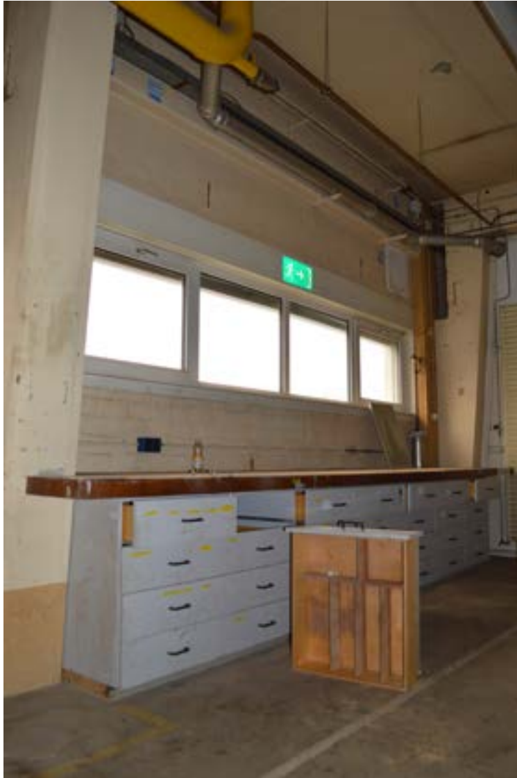
afbeelding 296. De zuidgevel van de timmerwerkplaats (085). De betonconstructie werd voorzien van vulmuren uit kalkzandsteen. Hier werd plaatselijk een opbergmeubel met werkblad gerealiseerd. Het venster werd secundair ingebracht (1990 >).
