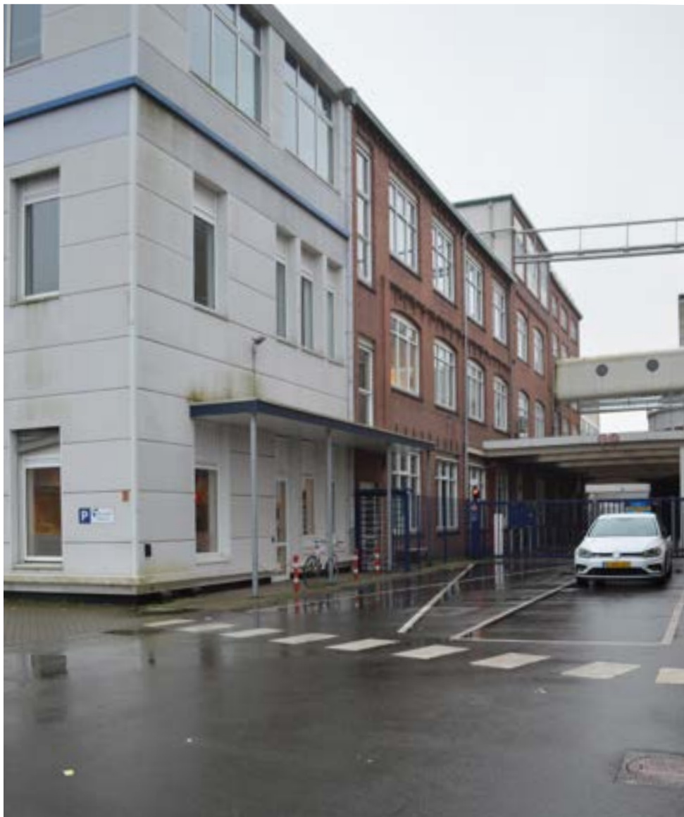
afbeelding 23. Overzicht van de noordgevel van gebouw 1 en de fabrieksstraat (XXd), gezien vanuit het noordoosten. Het meest oostelijke deel van de gevel werd bedekt met gevelpanelen (XXd), de rest van de gevel is wel zichtbaar, deze werd uitgevoerd in schoonmetselwerk in kruisverband.
