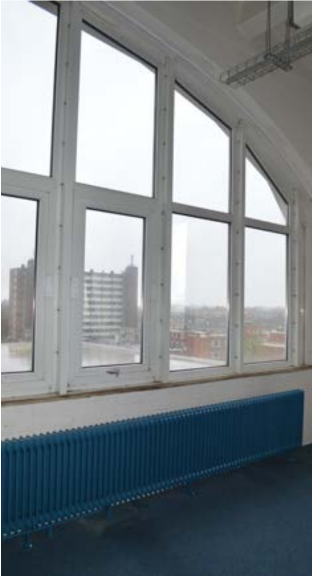
afbeelding 336. Fragment van het grote getoogde kunststof kozijn in de westgevel (XXd).
