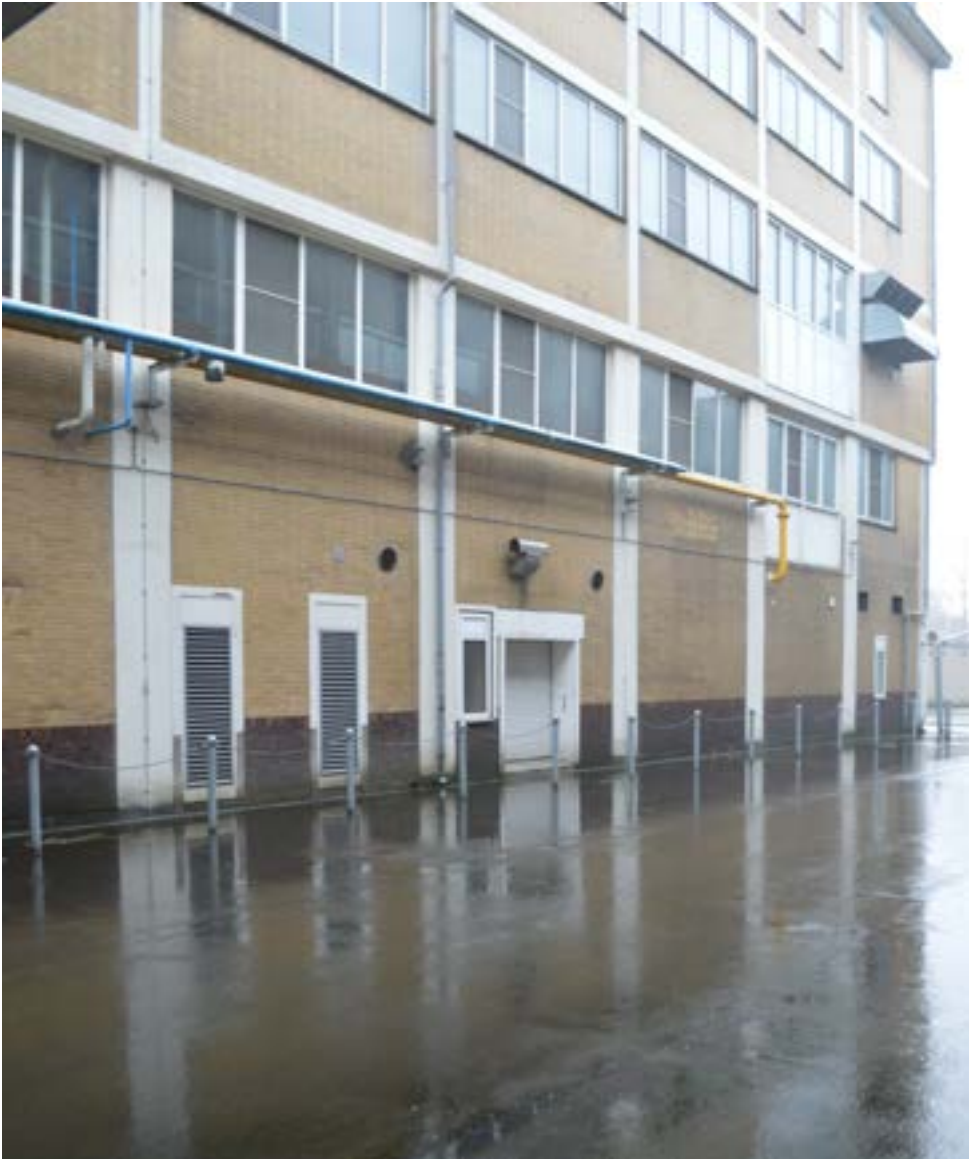
afbeelding 261. De noordgevel van gebouw 6, ter hoogte van het maaiveld. Het huidige buitenschrijnwerk op de begane grond dateert grotendeels uit het laatste kwart van de 20ste eeuw (XXd).
