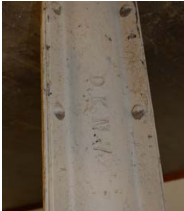
afbeelding 117. Twee details van de staalconstructie; de kolommen bestaan uit de buisprofielen uit de bouwtijd (DKN 7 1/2 , 1904), de balklaag uit I-profielen (Hoesch N.P. 21, 1904).
