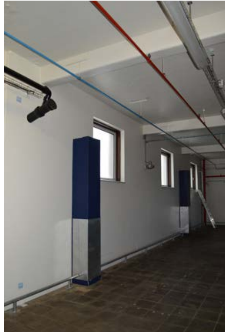
afbeelding 237. Detail uit voorgaande afbeelding. De kozijnen dateren uit 1961, de ramen werden in het laatste kwart van de 20ste eeuw voorzien (XXd). De ca. 2 meter hoge kolommen tegen de zuidgevel houden geen verband met de constructie.
