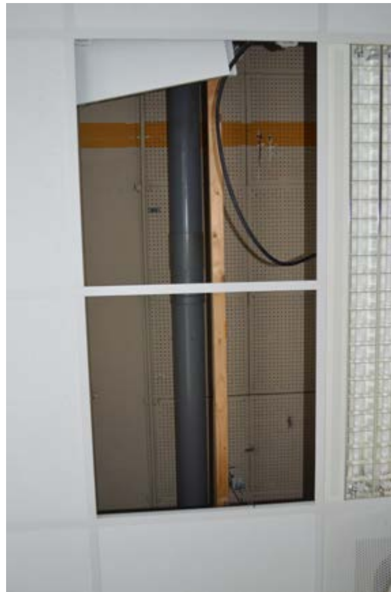
afbeelding 254. Detail uit voorgaande afbeelding van het verlaagde plafond; hierboven zit nog een verlaagd plafond bestaande uit geperforeerde panelen.
