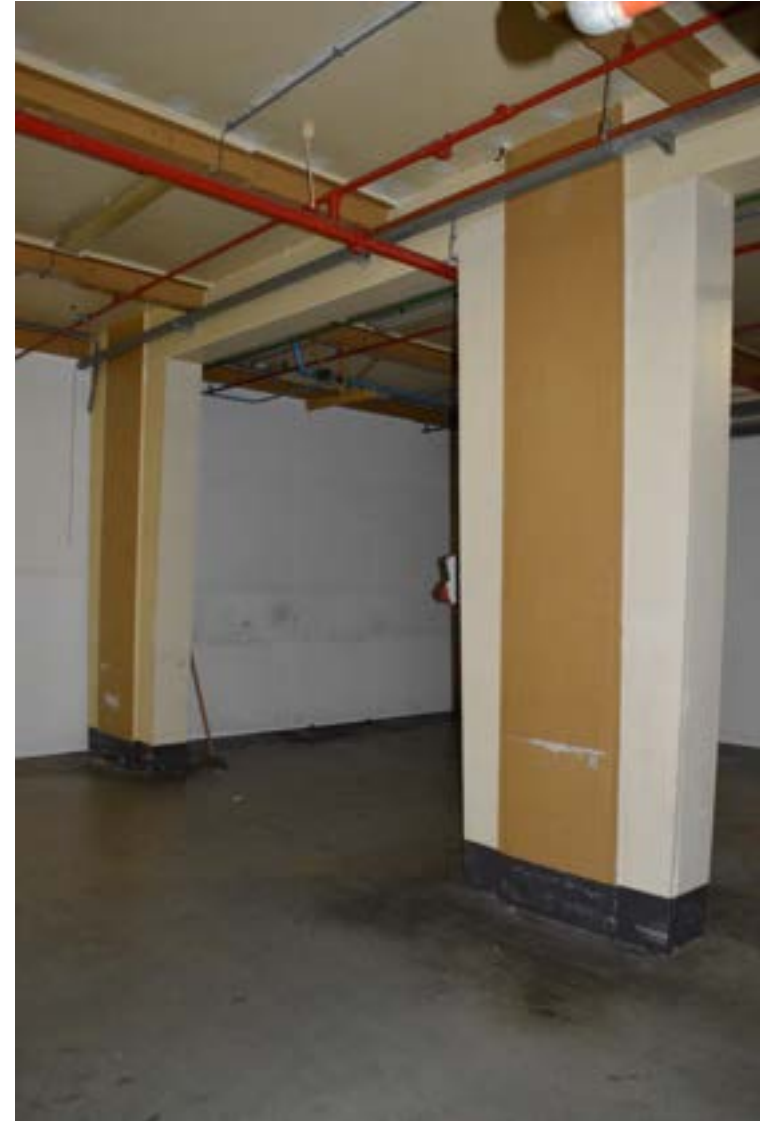
afbeelding 290. De kolommen uit de bouwtijd (1950, donkergele afwerking), werden in 1953 versterkt met uit gewapend beton gestorte tussenportalen (1953, wit-gele afwerking) en stalen balklaag voor de realisatie van een extra verdiepingvloer.
