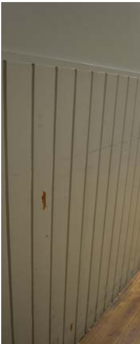
afbeelding 110. Detail uit ruimte 026; lambrisering uit houten delen met v-groef.
