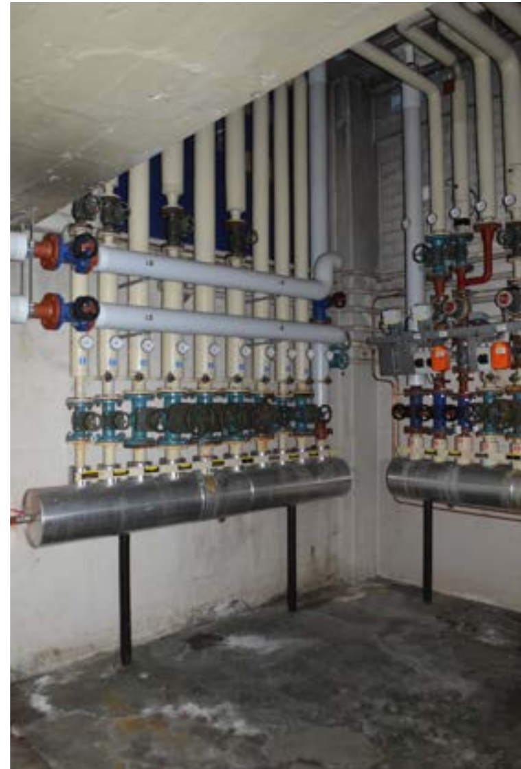
afbeelding 284. De CV-ruimte, gezien in westelijke richting.
