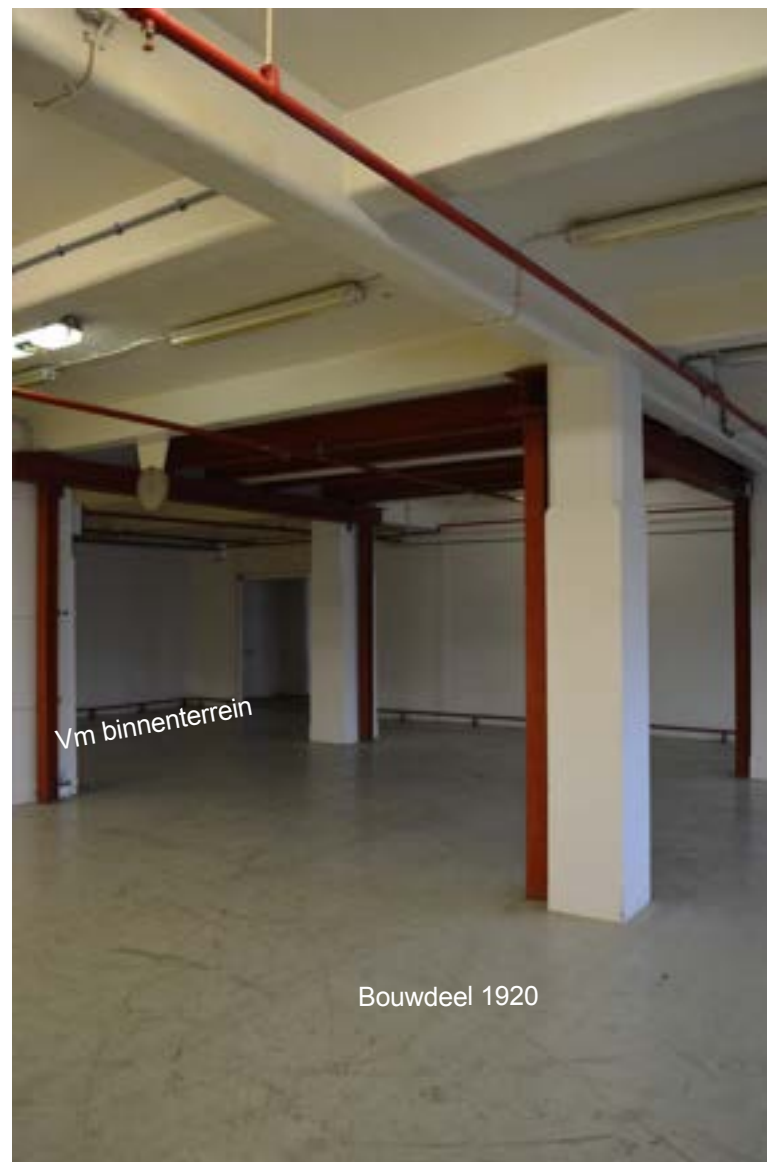
afbeelding 176. De kolommen van het in 1920 gerealiseerde bouwdeel werden qua vormgeving afgestemd op die uit 1913. De rij rechthoekige kolommen in de ruimte duiden de contour van het voormalige open binnenterrein (bebouwd in XXb) aan de noordzijde aan.
