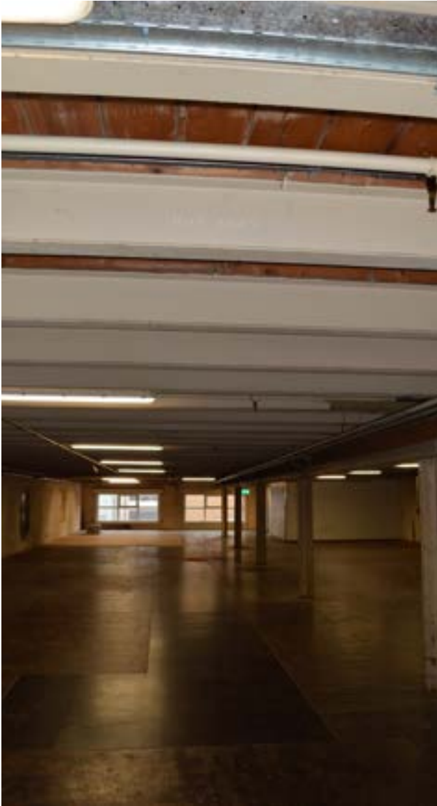
afbeelding 116. De derde verdieping van het pakhuys 037, gezien richting de noordgevel. In de noordoosthoek werd hier eind 20ste eeuw een noodtrappenhuis voorzien (XXd).
