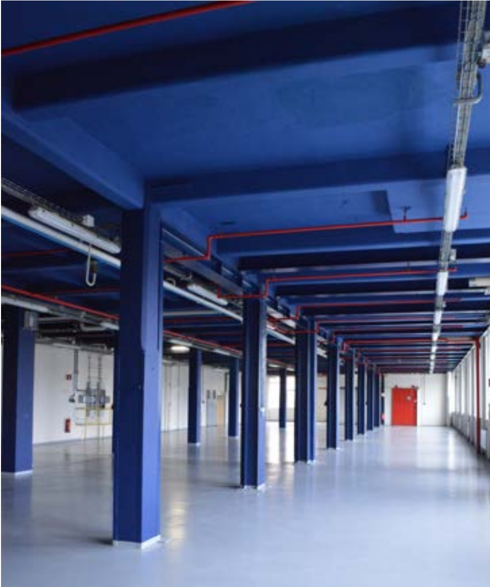
afbeelding 179. De tweede verdieping van gebouw 2 (pakkerij 2, 034), gezien in oostelijke richting. Op de voorgrond het in 1920 gerealiseerde deel. De kolommen werden in deze fabriekshal voorzien van stalen hoekijzers.
