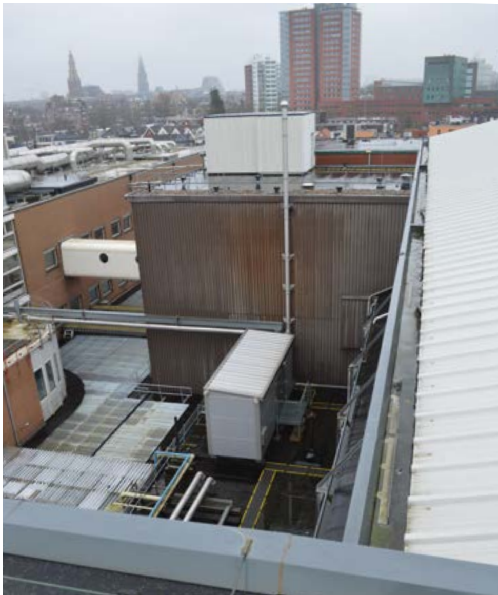
afbeelding 21. Gedeelte van het dak en de achtergevel van gebouw 1, gezien vanuit het westen. De westelijke travee van gebouw 1 was oorspronkelijk in gebruik als pakhuis, de huidige gevelbekleding bestaande uit bruinijzeren golfplaat werd in het laatste kwart van de 20ste eeuw aangebracht (XXd).
