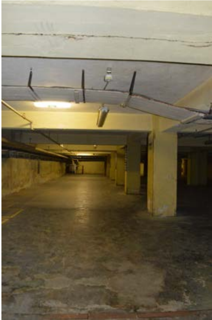
afbeelding 215. De kelder 015 van gebouw 4 gezien richting het oosten (1925). De kelderconstructie bestaat uit een dubbele rij gewapende betonkolommen met een balklaag uit gewapende betonnen balken.
