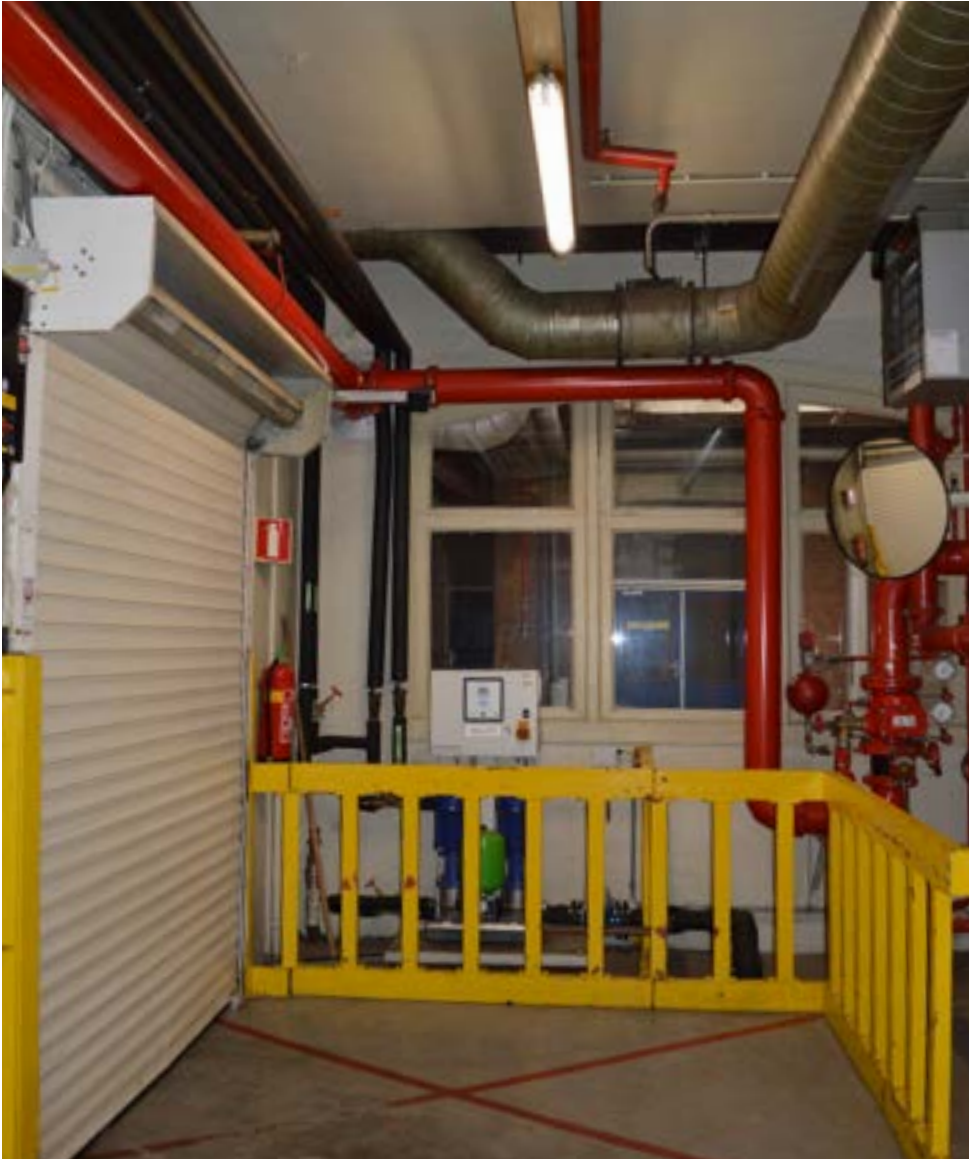
afbeelding 67. Gang 047 aan de westzijde, gezien richting de noordgevel. Het betreft hier een kozijn en raamhout uit de bouwtijd. Aan de linkerzijde werd eind 20ste eeuw een garagedeur voorzien (XXd).
