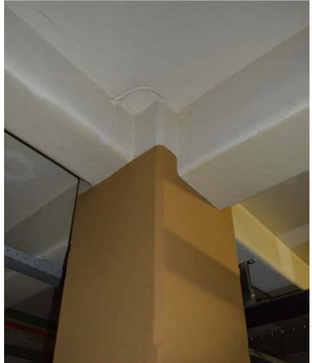
afbeelding 220. Detail van betonconstructie uit voorgaande afbeelding. De kolommen zijn voorzien van vellingkanten de betonnen balken van afgeronde hoeken (1925).
