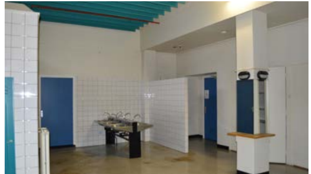
afbeelding 233. De kleed- en wasruimte 062, gezien richting het noordwesten en richting het zuidoosten (interieurafwerking XXd). De constructie bestaande uit betonnen kolommen en balken (1925) is enigszins verscholen - en ondanks de verbouwingen uit 1961 en XXd - nog geheel aanwezig in het gebouw.
