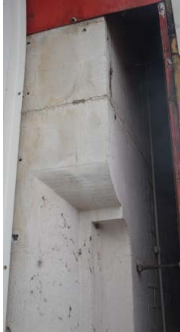
afbeelding 19. Twee details uit voorgaande afbeelding van de dagkant van de poortdoorgang waar de gevelpanelen (XXd) gedeeltelijk werden weggenomen. Het basement, aanzetstenen en sluitsteen van de rondboog werden vervaardigd uit gefijnde geprofileerde zandsteenblokken (1904), de overige onderdelen van de dagkant werden vervaardigd uit geprofileerde bakstenen, die later werden voorzien van pleisterwerk.
