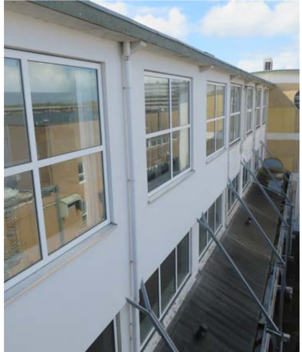
afbeelding 212. De noordgevel van gebouw 4, gezien vanaf het dak van gebouw 1 (oosten). Alle huidige kozijnen werden in het laatste kwart van de 20ste eeuw vernieuwd. Kort na 1950 werd de luchtbrug tussen gebouw 1 en 6 langs de noordgevel (tweede verdieping) van gebouw 4 gerealiseerd.
