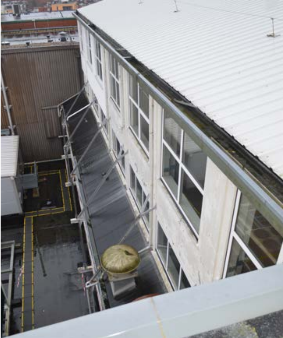
afbeelding 211. De noordgevel van gebouw 4, gezien vanaf het dak van gebouw 6 (westen). In 1952 werd de vierde verdieping opgehoogd waarbij ook de huidige grotere gevelopeningen van deze verdieping werden voorzien.
