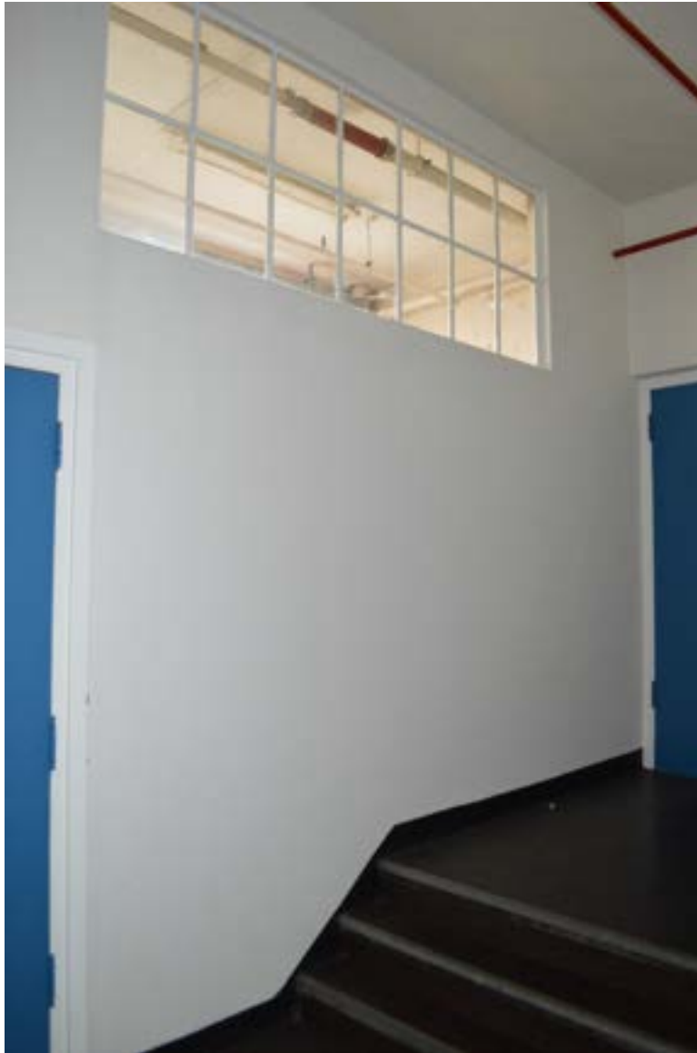
afbeelding 234. De gang naar de traphal 041 op de tweede verdieping, in de aanbouw aan de zuidoostzijde van gebouw 4 (1925). Hier resteert nog een hooggeplaatst raam uit de bouwtijd van gebouw 4, voorzien van ijzeren roeden (1925).
