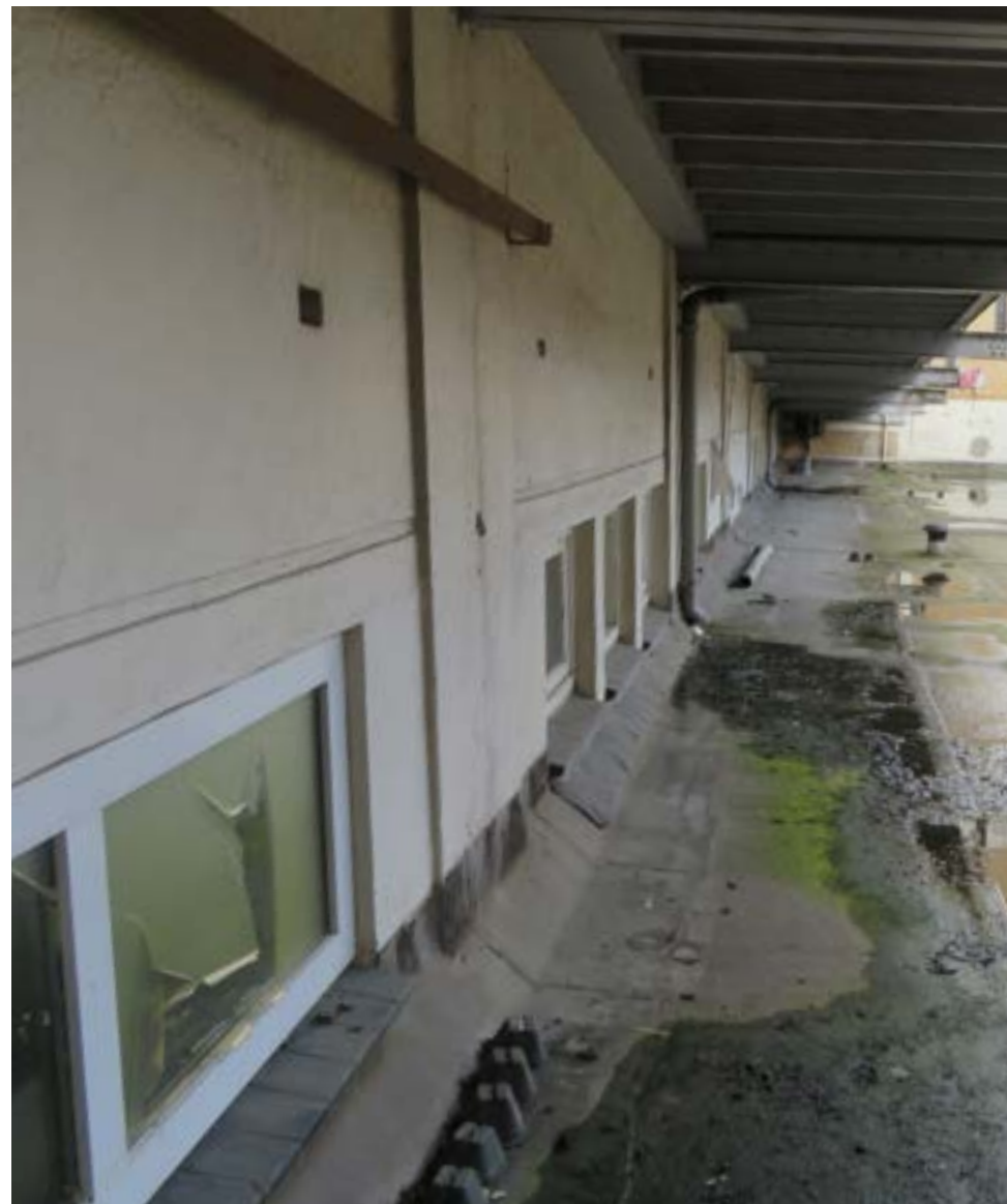
afbeelding 214. De noordgevel van gebouw 4 en aansluiting op de aanbouw aan de noordzijde (1967). In 1967 werd het huidige platte dak op de aanbouw voorzien.
