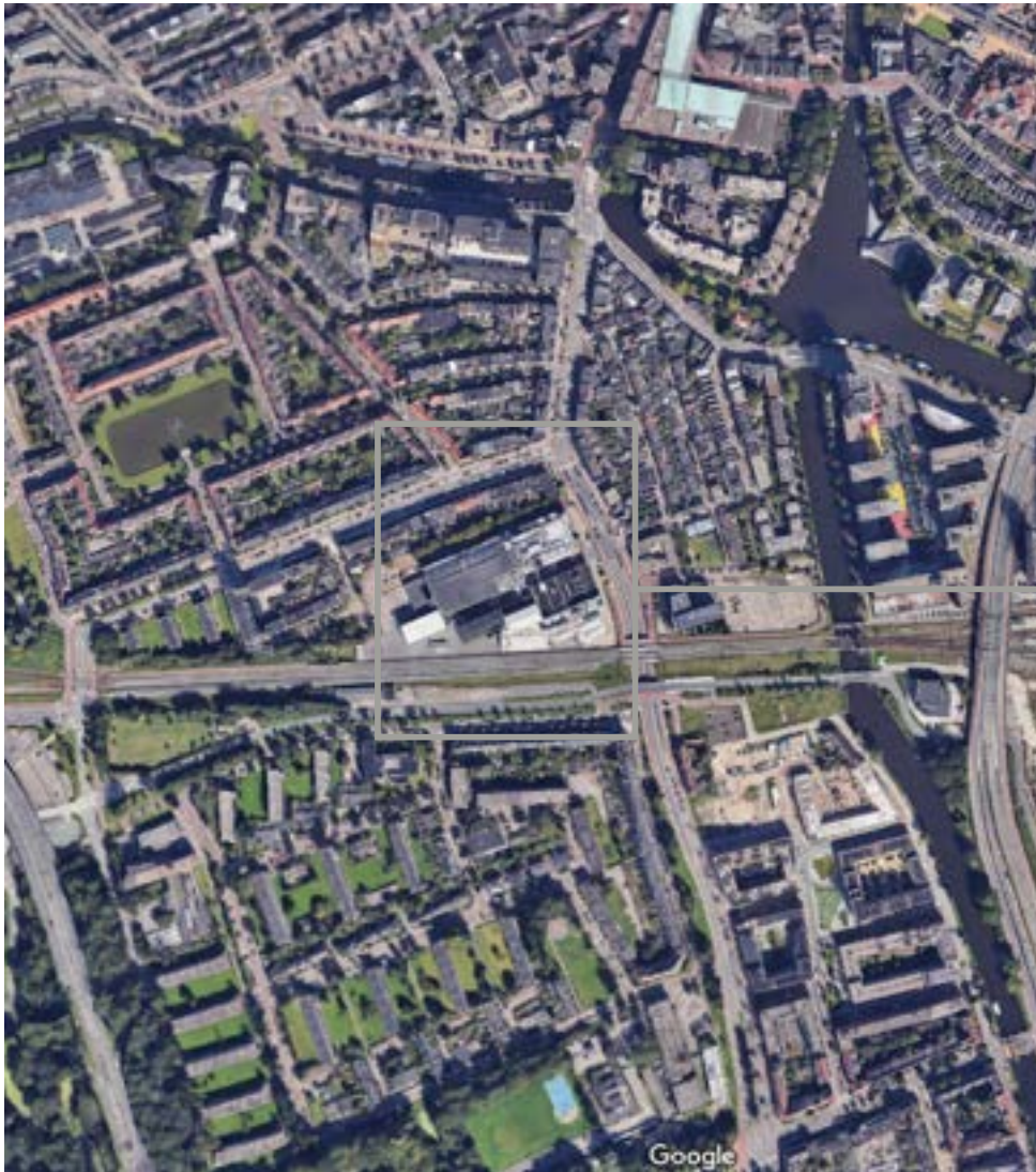
afbeelding 2. Bovenaanzicht van de omgeving van Paterswoldseweg 43 (noordgericht). De voorgevel aan de Paterswoldseweg wordt in het voorliggende rapport aangeduid als de oostgevel. Bron: Google Maps 2024.
