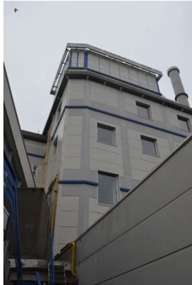
afbeelding 145. De zuidwesthoek van gebouw 2, met afgeschuinde hoek (1920). De dakopbouw werd eind 20ste eeuw gerealiseerd (XXd), ten behoeve van een geuremissie-installatie.
