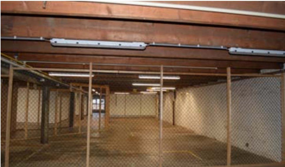
afbeelding 129. Magazijn 030, in de pakhuistravee. Het dak wordt hier ondersteund door een houten balklaag, rustend op de staalconstructie die ook op alle onderliggende verdiepingen voorkomt (1904).
