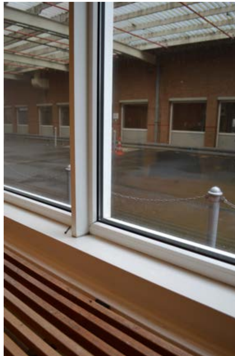
afbeelding 70. Detail van kunststof kozijn kantoren noordzijde (XXd).
