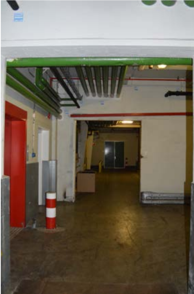
afbeelding 287. De gang op de begane grond van gebouw 6 (ruimte 077), gezien richting het westen, met aan de linkerzijde de goederenlift en doorgang naar het trappenhuis.
