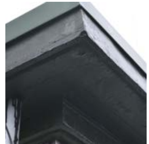
afbeelding 276. De dakopbouw van de aanbouw aan de zuidoostzijde (1950), het buitenschrijnwerk werd eind 20ste eeuw vervangen (XXd). Het metselwerk is gelijk aan dat van het hoofdgebouw.
