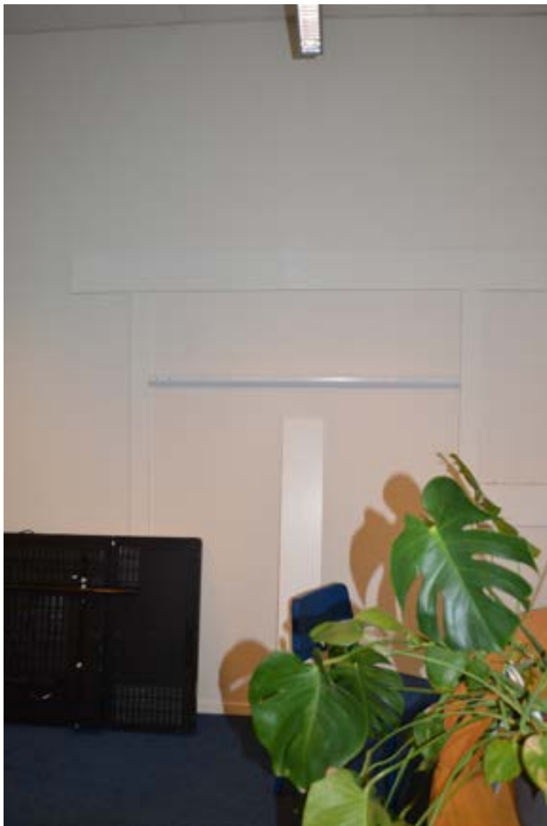
afbeelding 69. Detail van dichtgezette opening in de westmuur uit voorgaande afbeelding.
