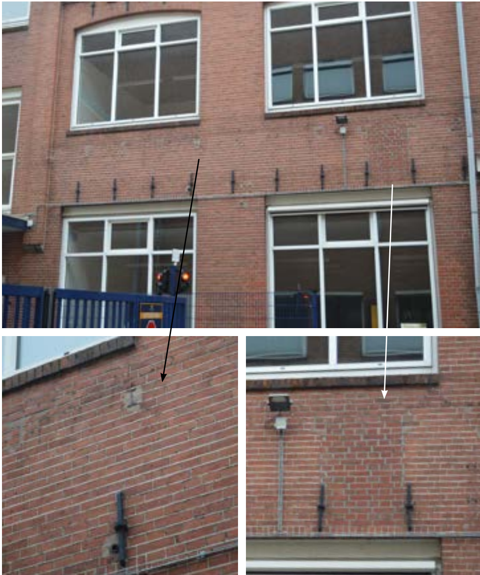
afbeelding 32. Fragment uit voorgaande afbeelding van de 8ste en 9de vensteras vanaf het westen. In de borstwering zijn sporen zichtbaar van stalen I profielen van een voormalige overkapping, ook bevindt zich hier een inboeting uit recenter metselwerk.
