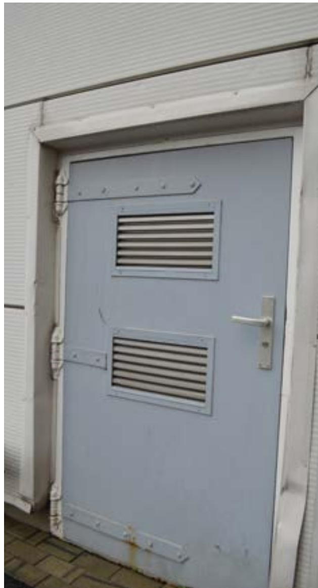
afbeelding 273. Detail van de buitendeuren uit de bouwtijd (1950). De roosters en het deurbeslag werden later voorzien.
