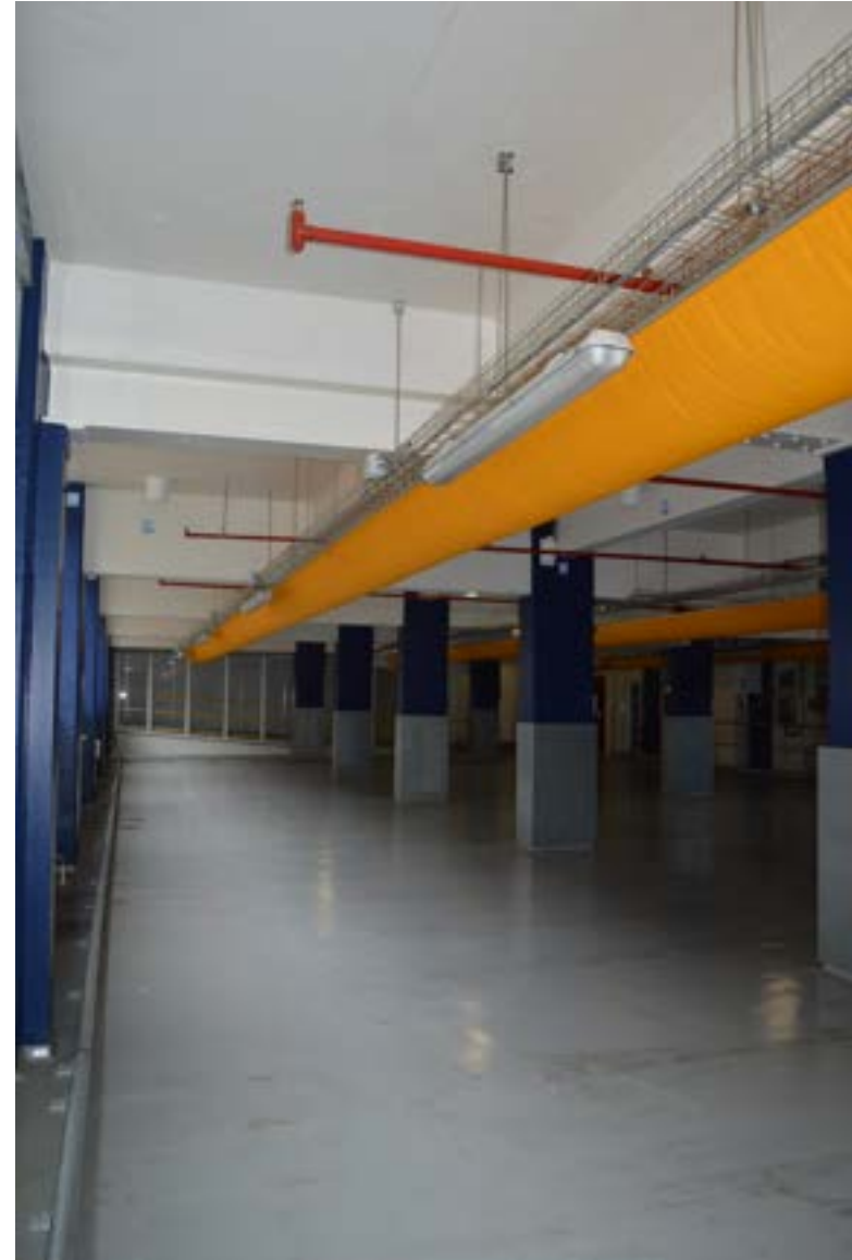
afbeelding 307. De fabriekshal op de eerste verdieping van gebouw 6, gezien in zuidwestelijke richting. De huidige verdiepingsvloer werd kort na de bouw (1950) in 1953 aangebracht. Het betonskelet, bestaande uit kolommen en balken dateert uit de bouwtijd (1950).
