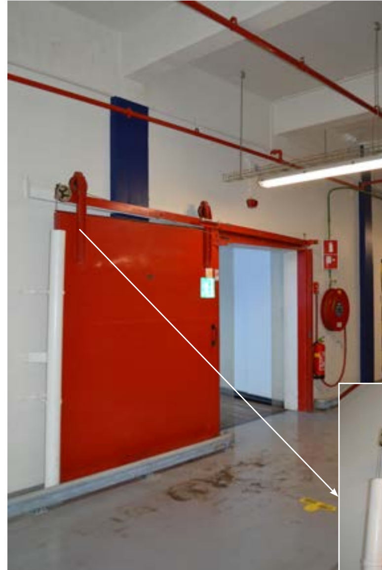
afbeelding 319. De branddeur tussen gebouw 4 en 6, voorzien van een hang-schuifrails met contragewicht (1950).
