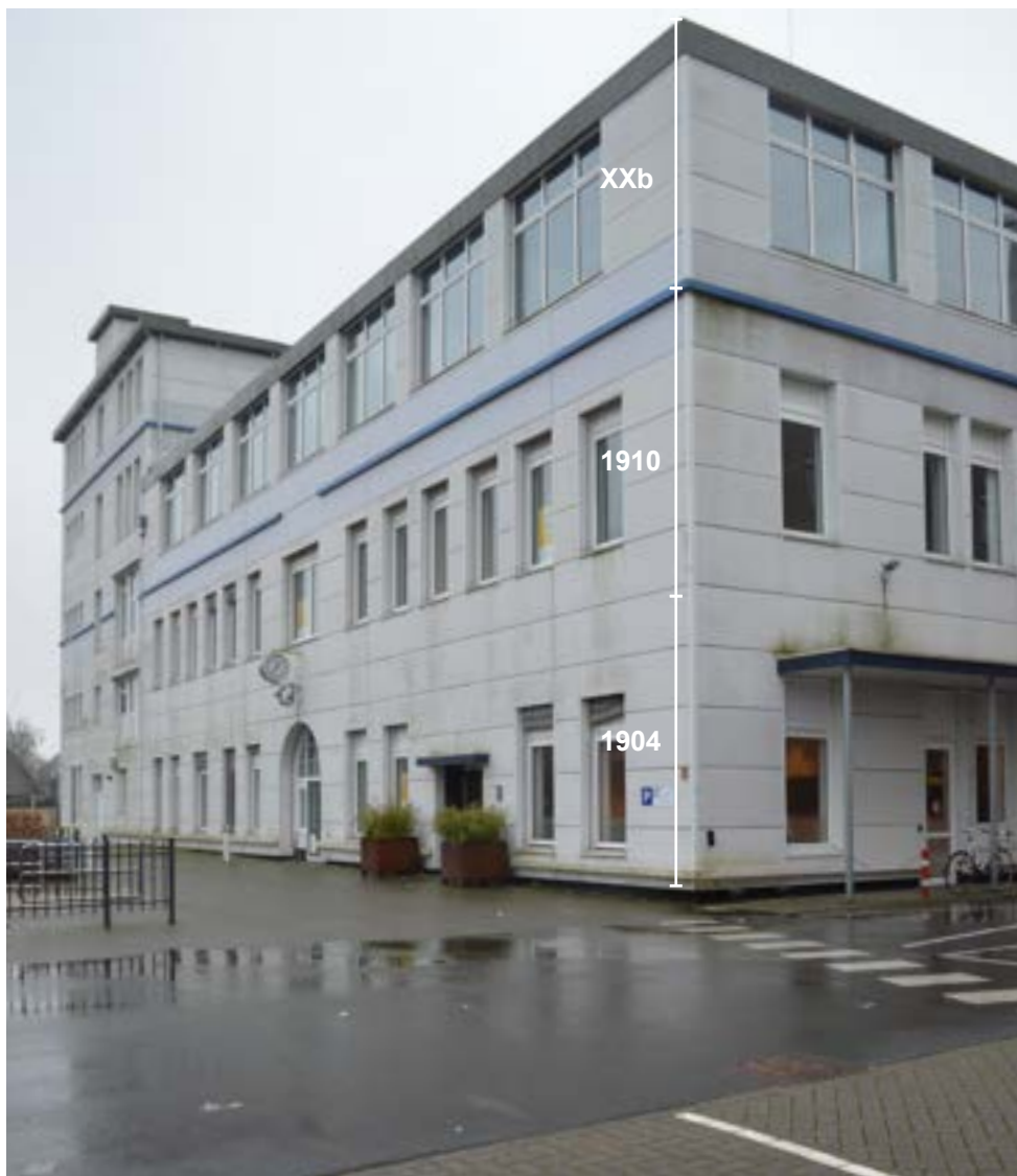
afbeelding 14. De voorgevel (oost) van gebouw 1, gezien vanuit het noordoosten. Al het schrijnwerk werd eind 20ste eeuw vervangen, eveneens werden toen de gevelpanelen aangebracht (XXd). De begane grond werd in 1904 gerealiseerd, in 1910 werd de tweede verdieping gebouwd en medio jaren 1930 de derde (XXb).
