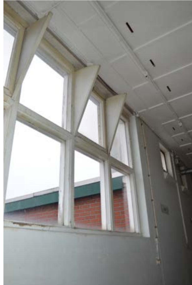
afbeelding 197. Venster (1953), voorzien van valramen, in de in 1953 gerealiseerde noordgevel.
