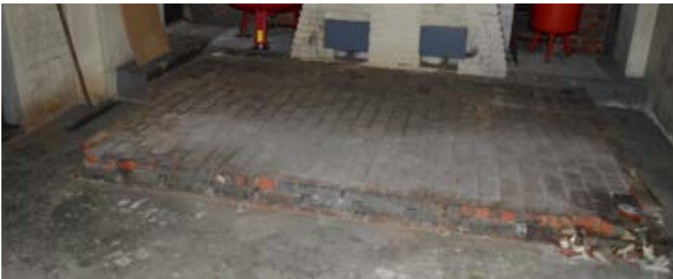
afbeelding 283. De CV-ruimte, gezien in oostelijke richting. Tegen de oostwand bevindt zich een gemetseld rookkanaal, met hiervoor een stookvloer vervaardigd uit klinkers op zijn plat. Voor de huidige luiken in het rookkanaal werden aangebracht, waren er andere openingen voorzien die later werden dichtgezet (pijlen).
