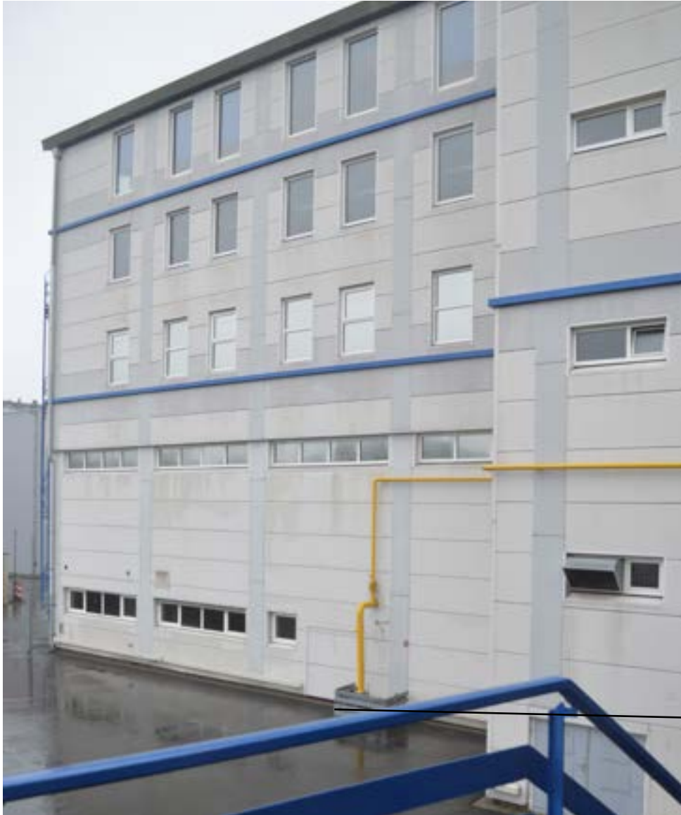
afbeelding 269. De zuidgevel, gezien vanaf het terras van de bedrijfskantie (gebouw 5). De vensters op de begane grond werden secundair ingebracht (XXd).
