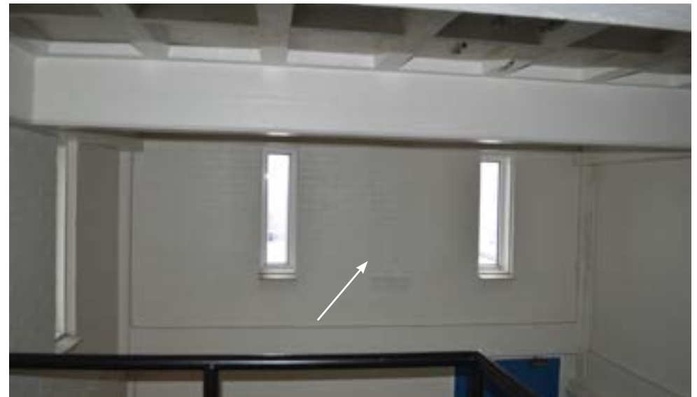
afbeelding 343. Ruimte 046, gelegen op het tussenbordes van het trappenhuis, gezien richting het zuidwesten.
