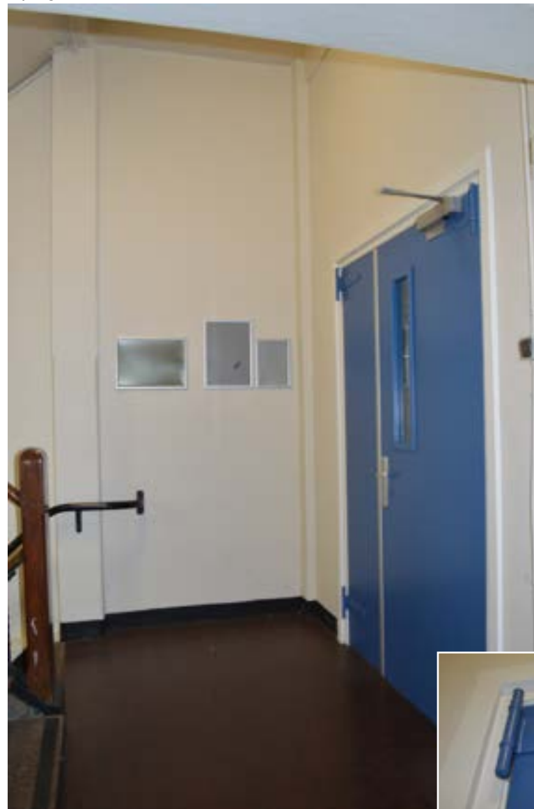
afbeelding 186. Het trappenhuis op de derde verdieping (1920) met deur naar de fabriekshal van gebouw 2. De deur bevat gelagerde scharnieren met gehengen.
