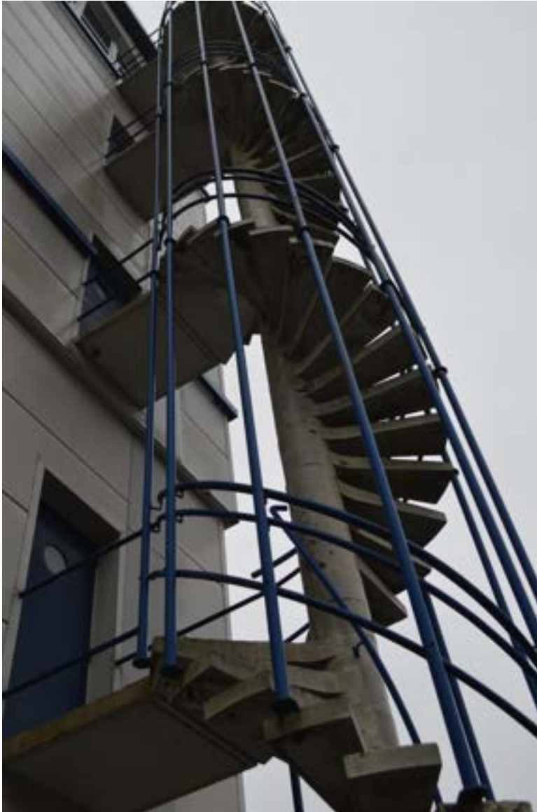
afbeelding 267. Detail van de betonnen spiltrap tegen de westgevel, die hier in 1961 werd gerealiseerd. De branddeuren op de 2de, 3de en 4de verdieping bestonden reeds (1950).
