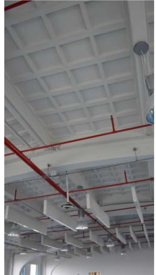
afbeelding 338. De dakconstructie werd vervaardigd uit Bimsbetonplaten (1950), voorzien van een rasterpatroon, deze rusten op getoogde betonnen portalen.
