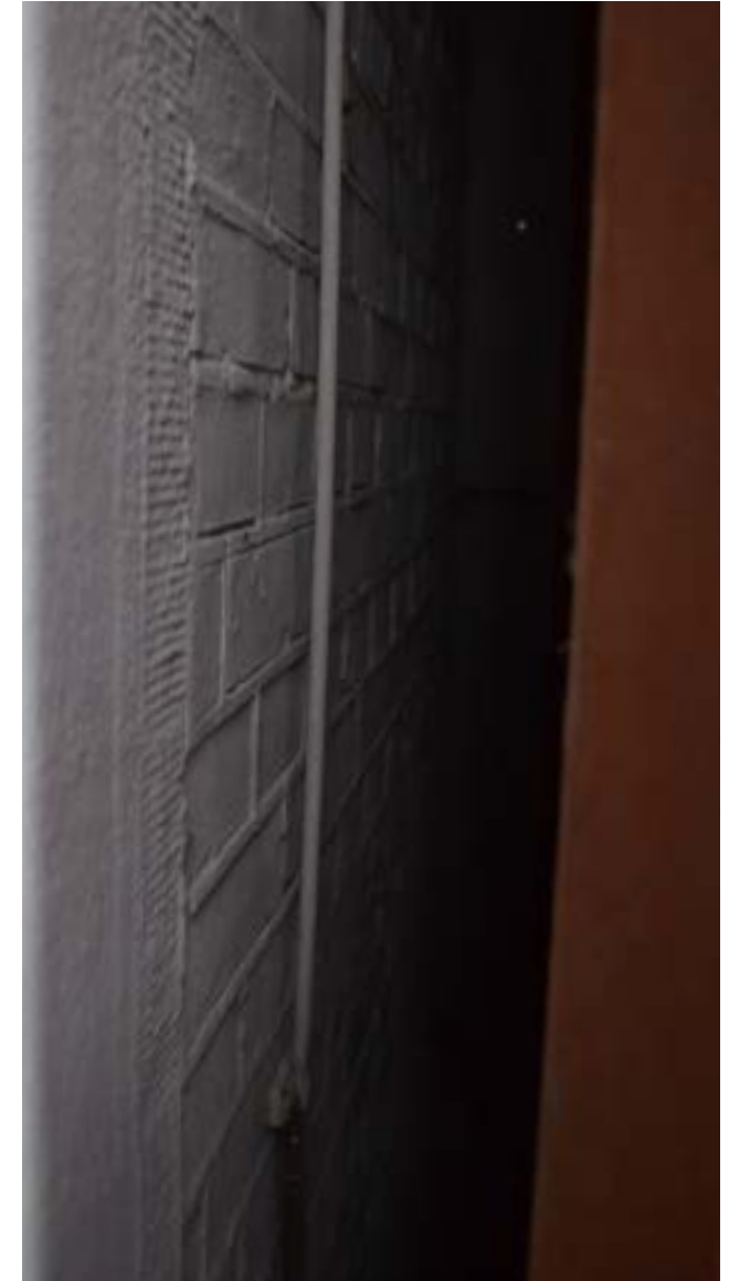
afbeelding 20. Zicht achter de gevelpanelen, hier is het metselwerk uit de bouwtijd zichtbaar (1904). Vanaf de jaren 1950-60 werd de gevel voorzien van een witte afwerking.
