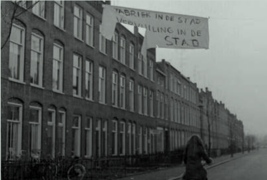
DE FABRIEK IN 1973, BRON: GRONINGER ARCHIEVEN
