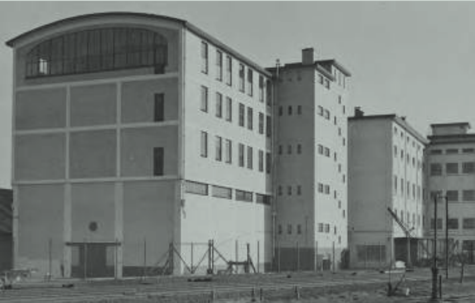
DE FABRIEK IN 1950, BRON: GRONINGER ARCHIEVEN
