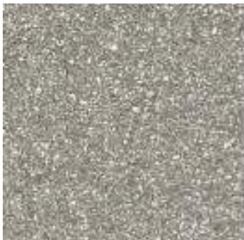
ASFALT MET SCHELLEN, FIETSPAD
