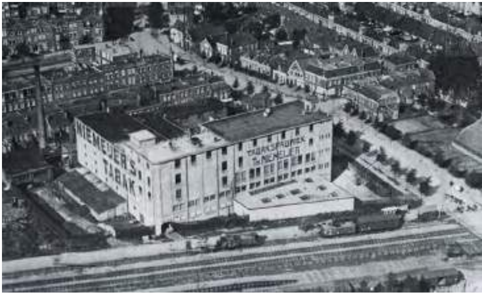
DE FABRIEK IN 1922, BRON: GRONINGER ARCHIEVEN
