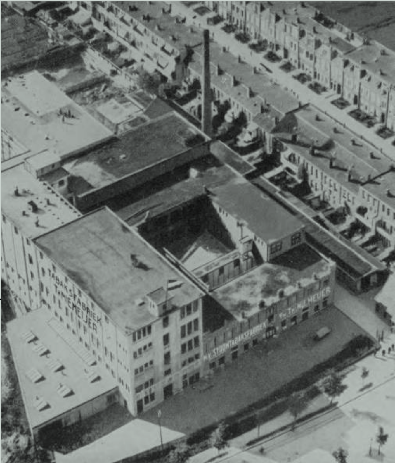
DE FABRIEK IN 1925, BRON: GRONINGER ARCHIEVEN
