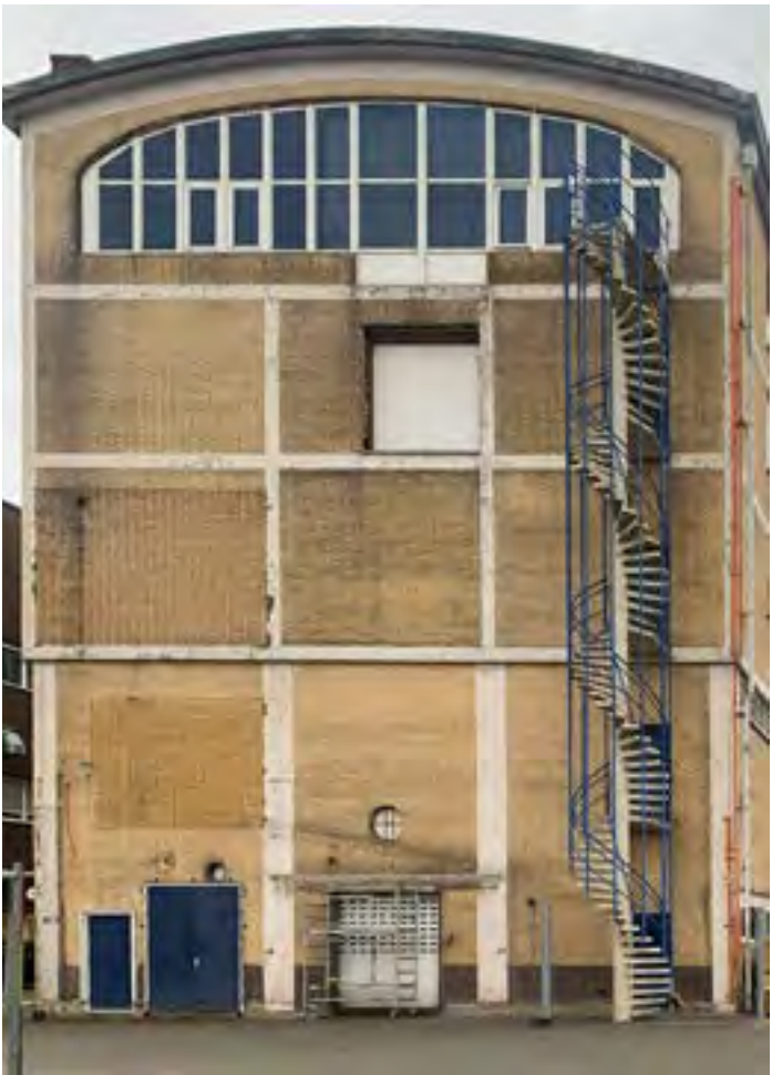
GROTE VENSTER WORDT NAAR ORGINELE STAAT GERESTAUREERD
