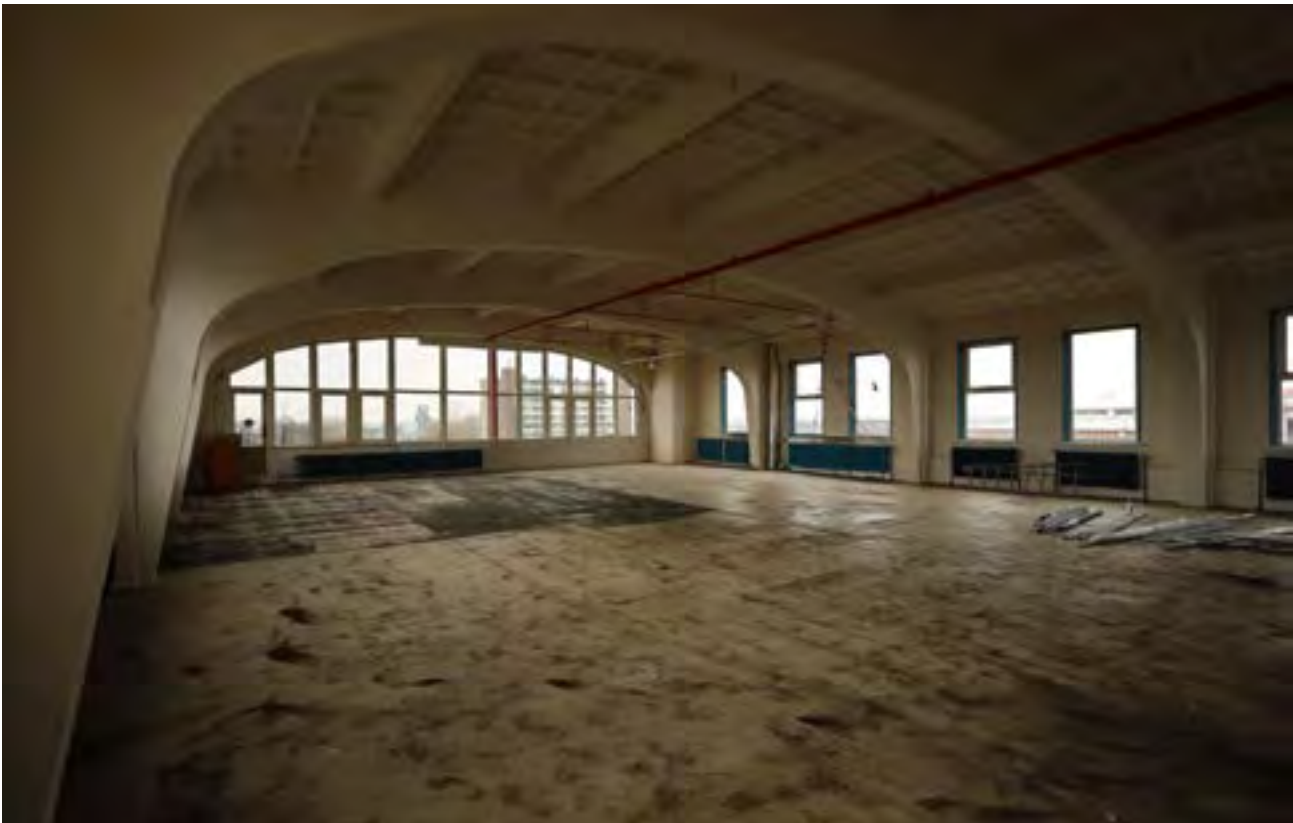
OPENHEID VAN DE PLATTEGROND TEN GEVOLGE VAN HET BETONSCHELET
