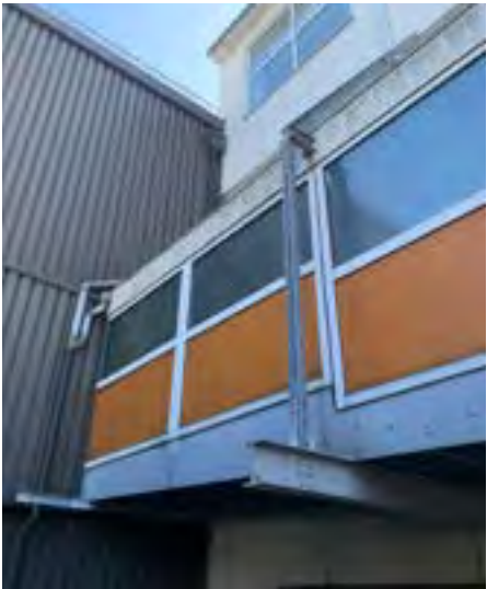
LUCHTBRUG WORDT VOLLEDIG VERWIJDERD
