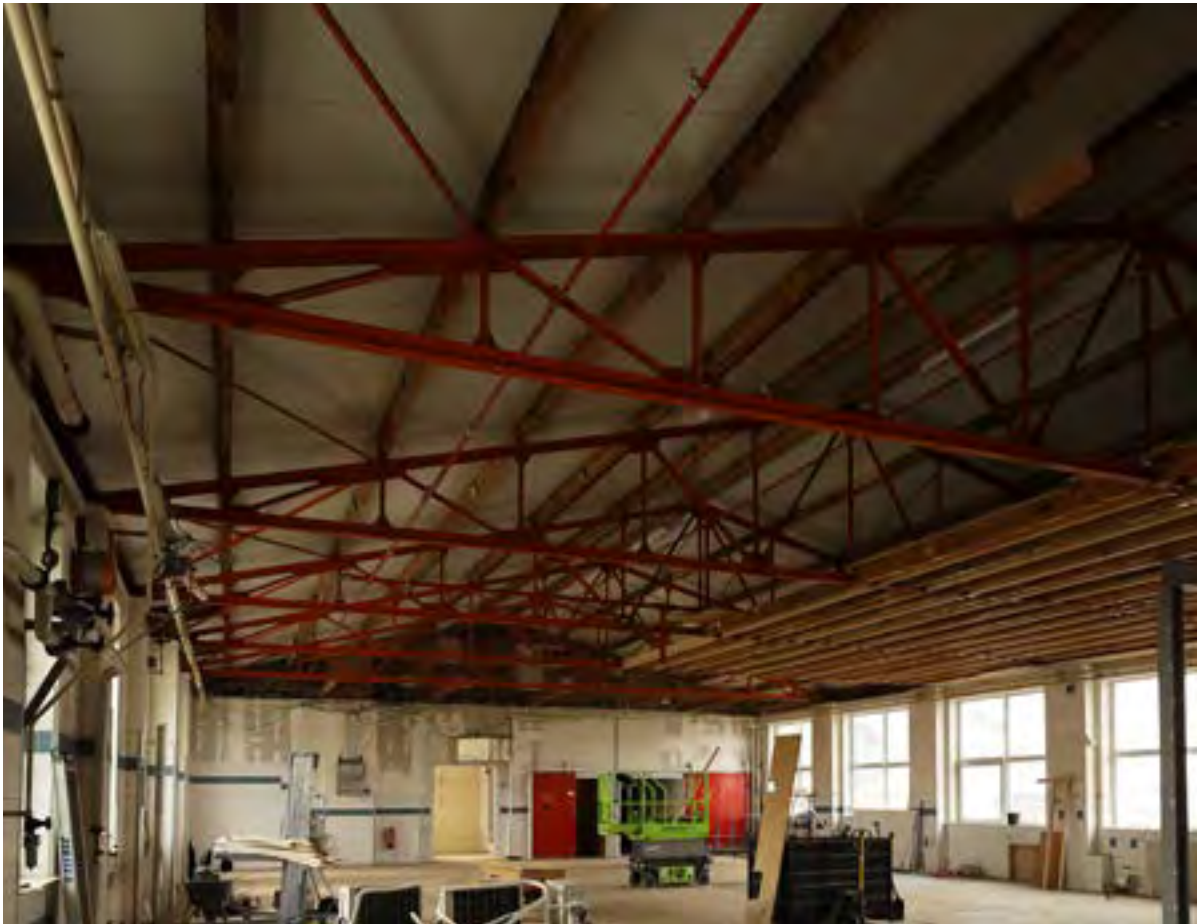
STALEN DAKSPANTEN GEBOUW 4
