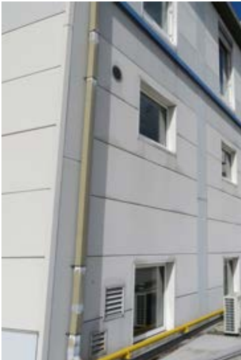
GEVELBEPLATING OP DE GEVEL.
