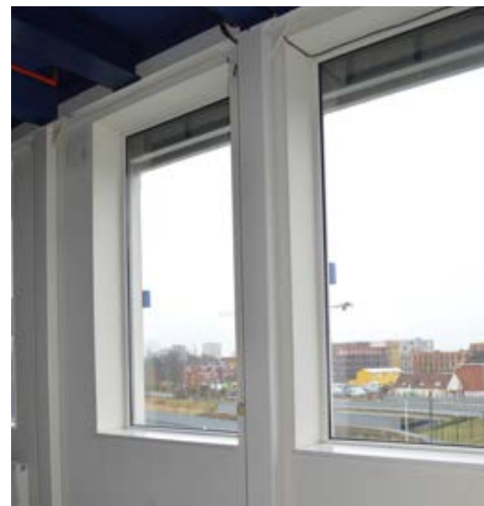
DE GEVELBEPLATING LOOPT DOOR OVER DE KOZIJNEN, WAARDOOR DE GEVELOPENINGEN MINDER VERTICAAL ZIJN.
