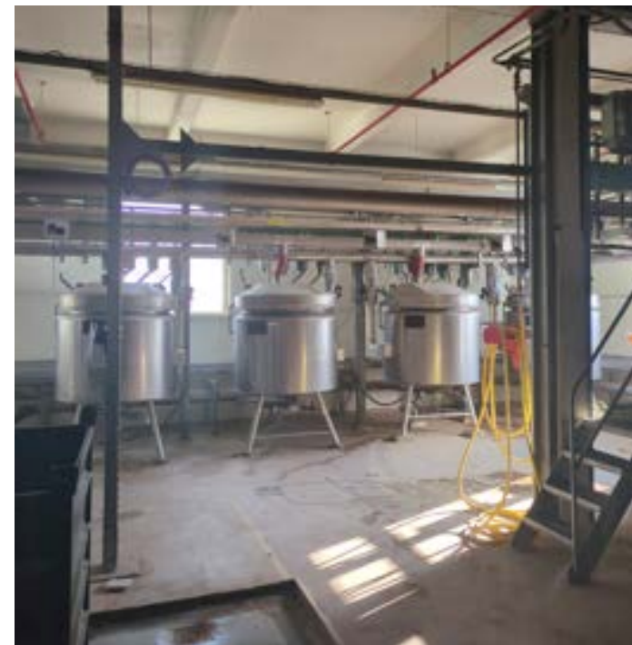
ENIGE BEHOUDEN MACHINES IN GEBOUW 2
