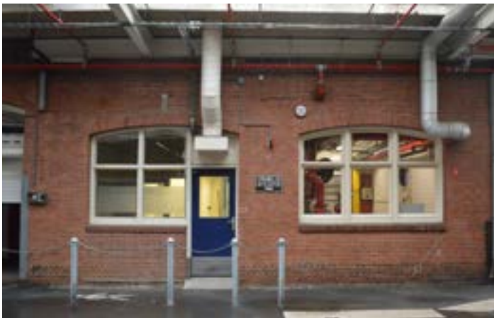
INBOETWERK BORSTWERINGEN MET GRIJZE CEMENTMORTEL EN AFWIJKENDE STEEN (2)
