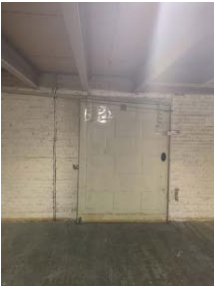
BRANDDEUR VAN GEBOUW 1 NAAR GEBOUW 4 (B)
