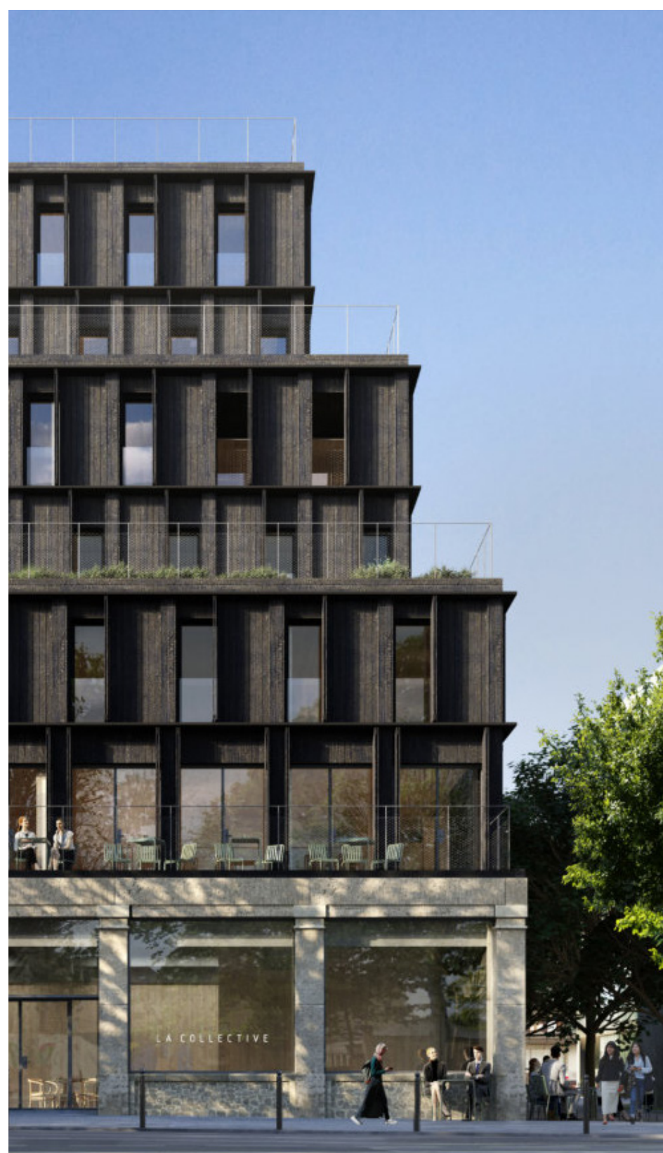
Houten veranda gebouw aan het park
